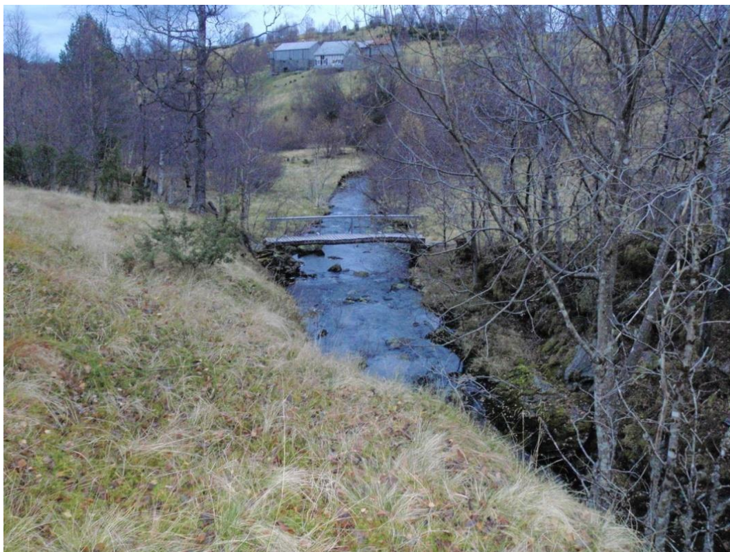
Bilde 9 a. Mellom Markafossen og kraftstasjon, Marka i bakgrunnen. 07.09.10 vannføring ca 60 l/s
