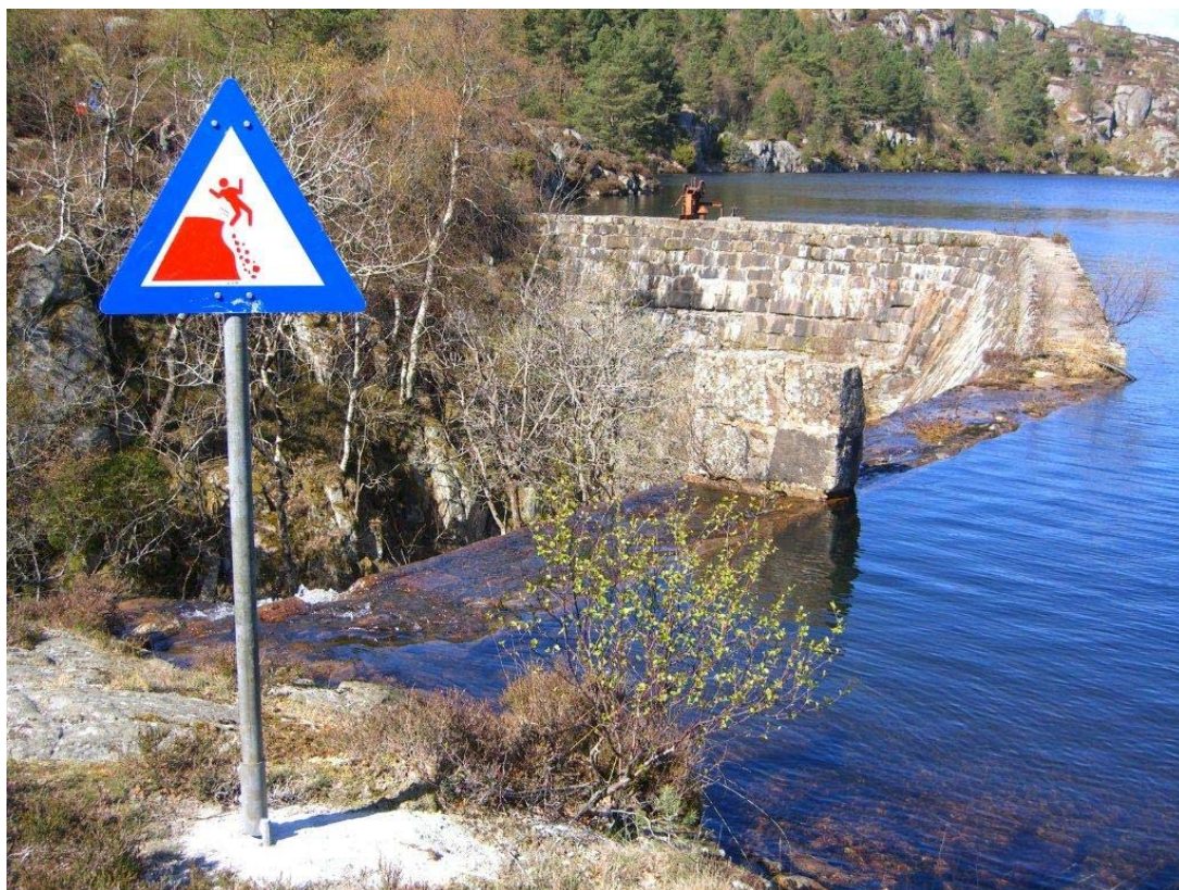
Dam Beiske. Flomløpet
