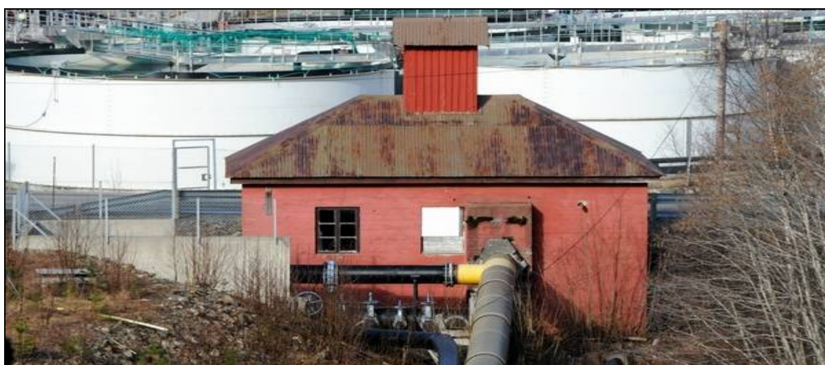
Figur 5. Anlegget har vanninntak i Vinsternesvatnet, som er oppdemmet, og er i dag regulert 2,3 m mellom kote 24,7 og 22,4 m (bilde øverst). Anlegget har også et inntak fra en dam nedenfor (bilde midten) som går ned til et gammelt kraftverk (bildet nederst) Ledningene går videre ned til anlegget fra samlestokken og under riksveien.
