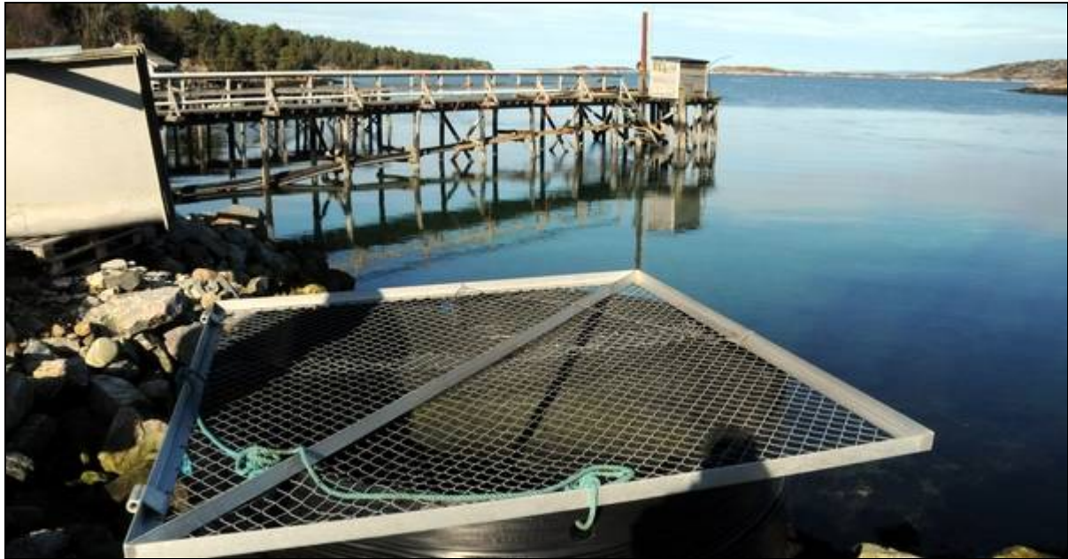
Figur 11. Marine Harvest Norway AS avd. Sagosen har sitt utslipp i Sagvågen. Her sees avløpskummen der ledningene ligger utover i vågen på sandbunn (til høyre i bildet).
