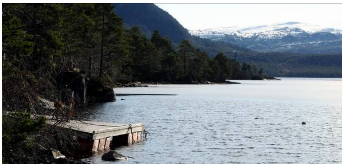
Figur 16. Anlegget har inntak av ferskvann i Vinsternesvatnet, som er regulert 2,3 m med en demning i utløpet.
