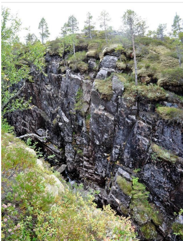
Figur 2.18. Utilgjengelig juv ved kote 100
