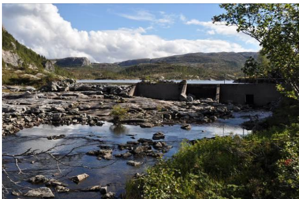
Figur 2.6. Dam ved Grovlivetnet
