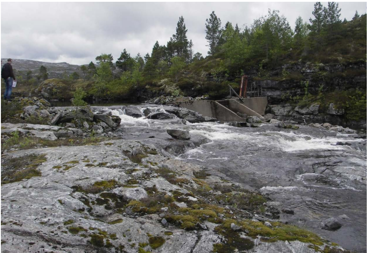
Figur 12 Eksisterende Dam Grovlivatn
