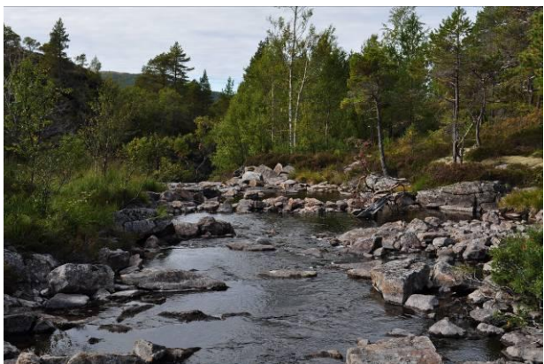
Figur 2.10. Området ved vei- og rørgateovergangen
