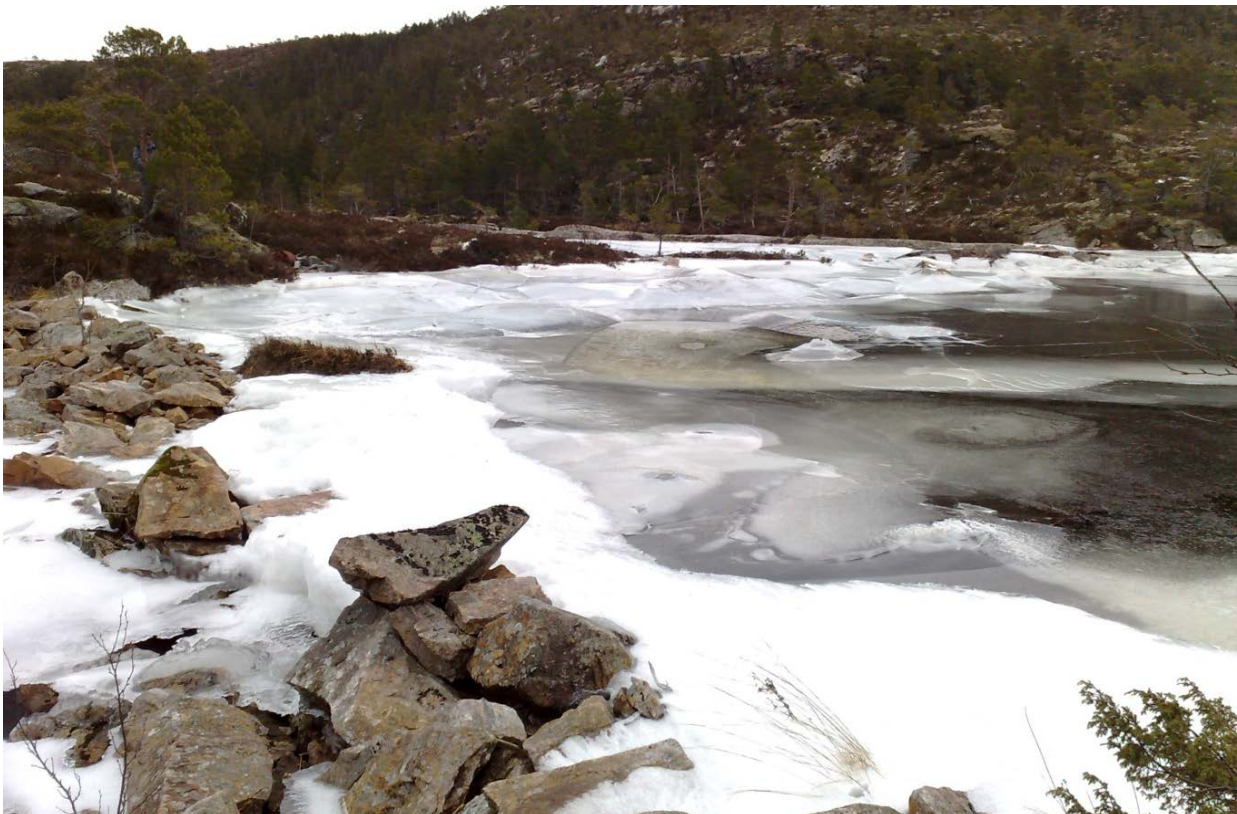
Figur 4 Steinfyllingsdam i framkant. Løftas utløp i bakkant.
