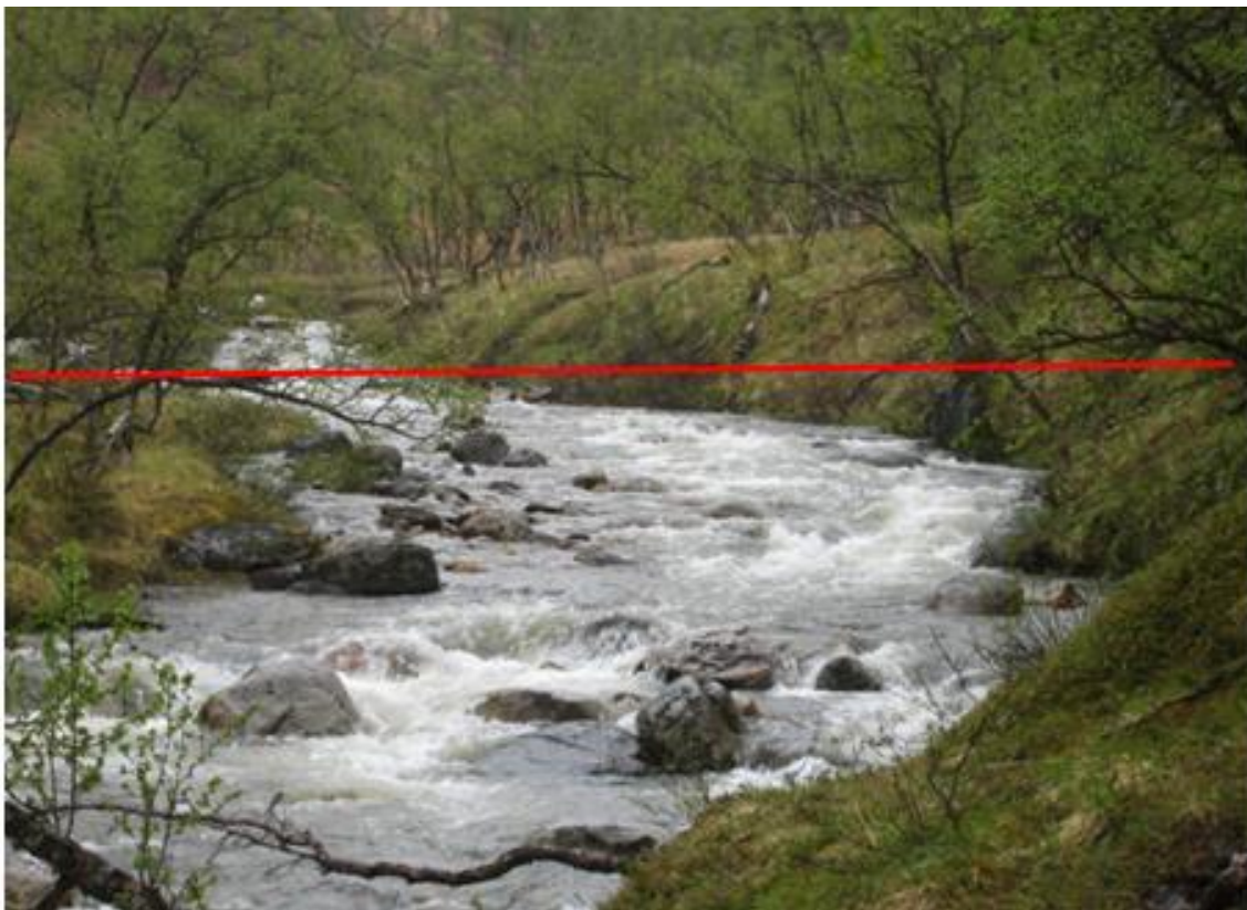
Bilde 2-1 Inntaksområde. Damkrone ved rød strek. Foto: Elvekraft
