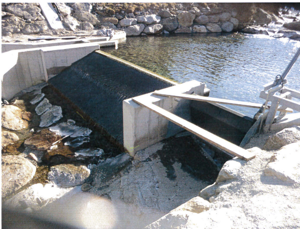
Figur 3 Eksempel på utforming av coandainntak
