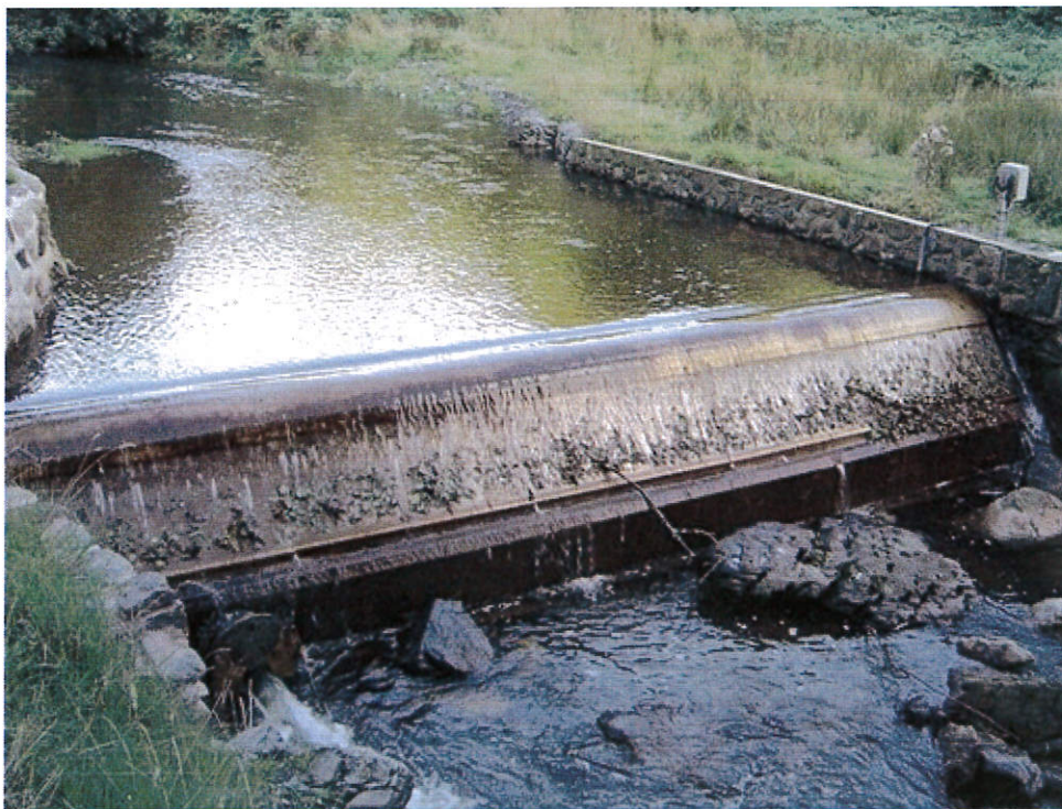
Figur 4 Eksempel på coandaiintak
