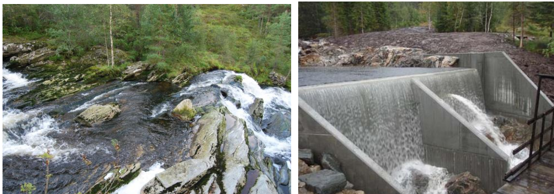
Figur 7, Damstad nedstrøms Kalstad bru, og prinsipp dam type.
