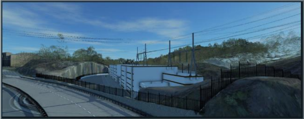
Illustrasjon VR bilde fra Ringeriksveien retning mot Sandvika (med innstrekksstativ på taket)
