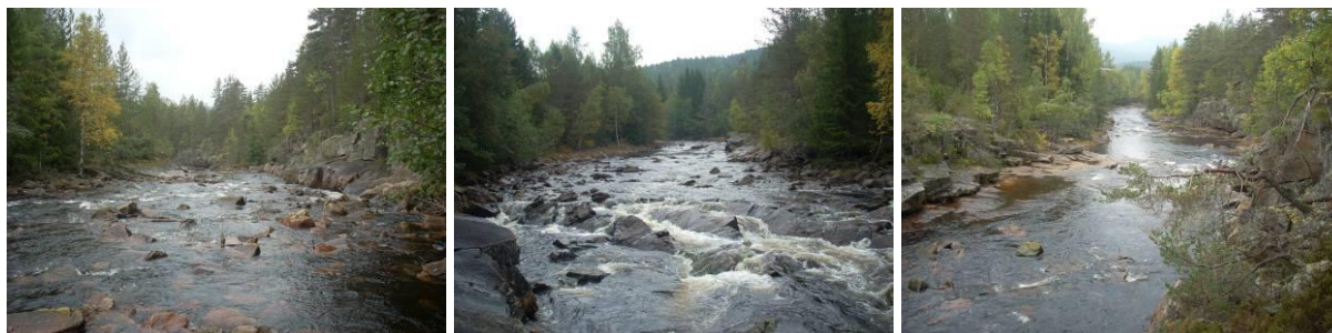
Bildene over viser inntaksområdet, samt inntaksbassenget opp mot kote 110.
