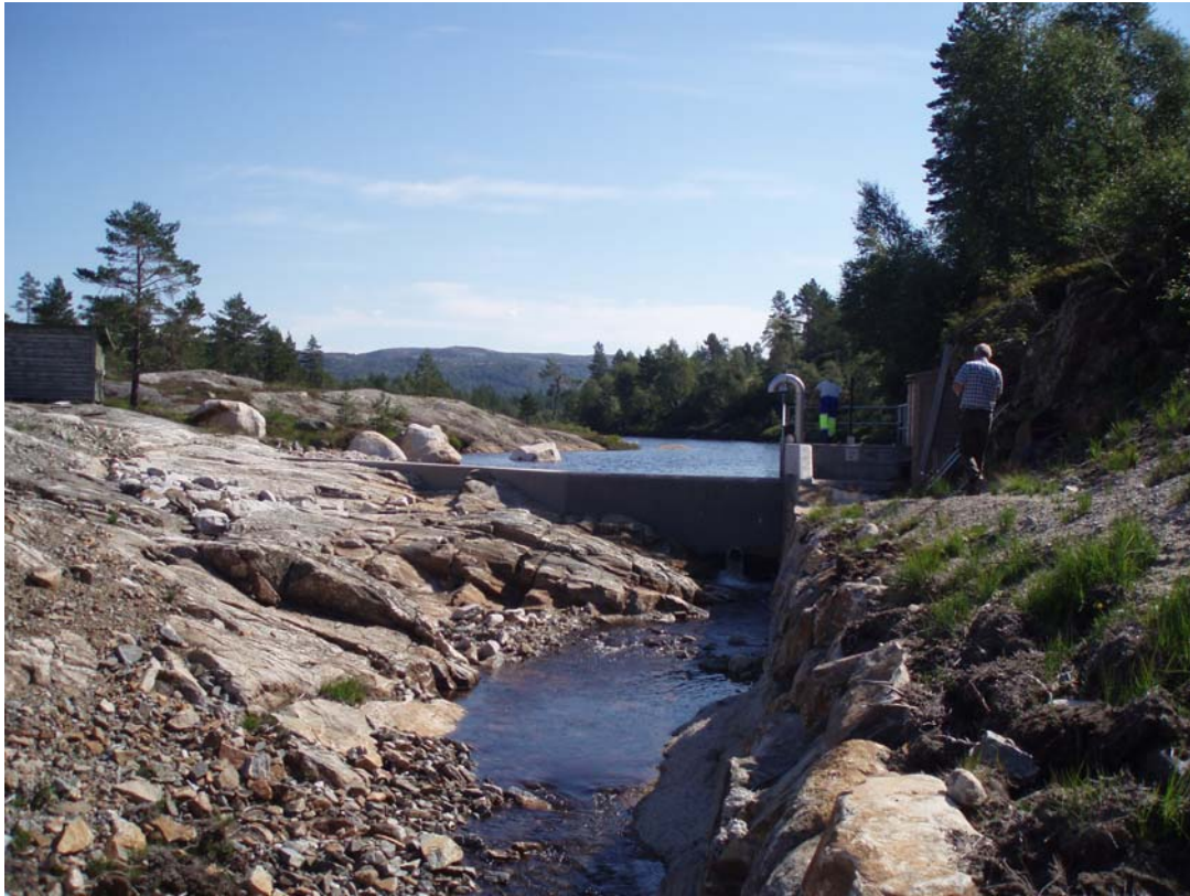
Bilde viser eksisterende dam og inntak til høyre, bilde tatt mot øst
