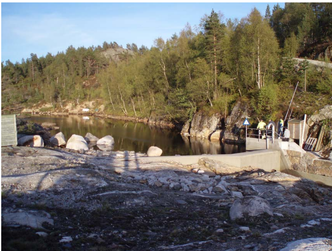
Bilde av eksisterende dam, tatt mot sydløst
