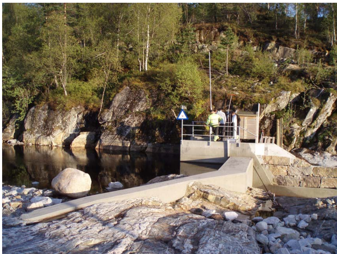
Bilde av eksisterende dam og inntak, bilde tatt mot syd
