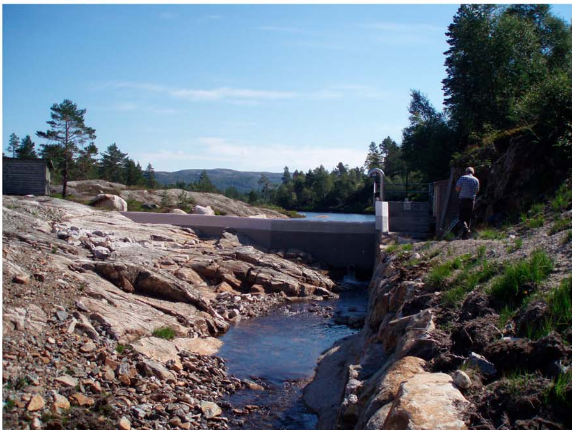
Bildene viser før (øvrste) og etter (nederste) heving av dam med 0,5 m, bildene tatt mot øst
