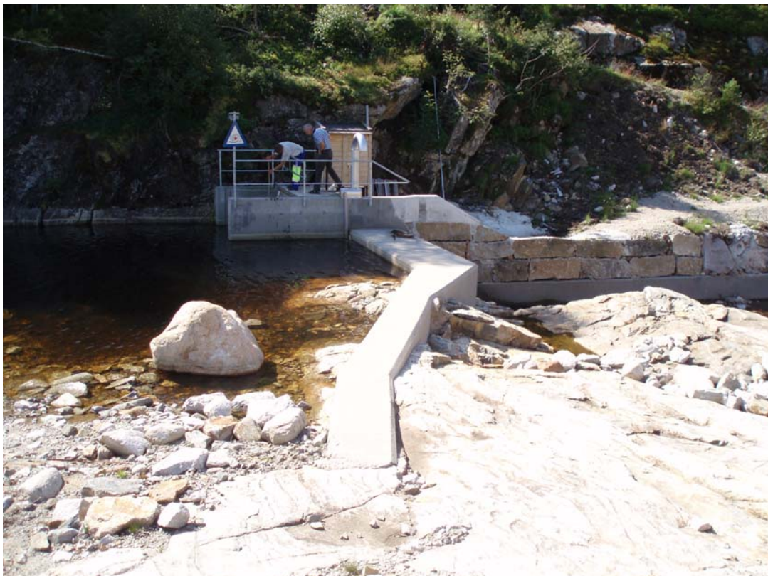
Bildet viser eksisterende dam og inntak til høyre, bilde tatt mot syd
