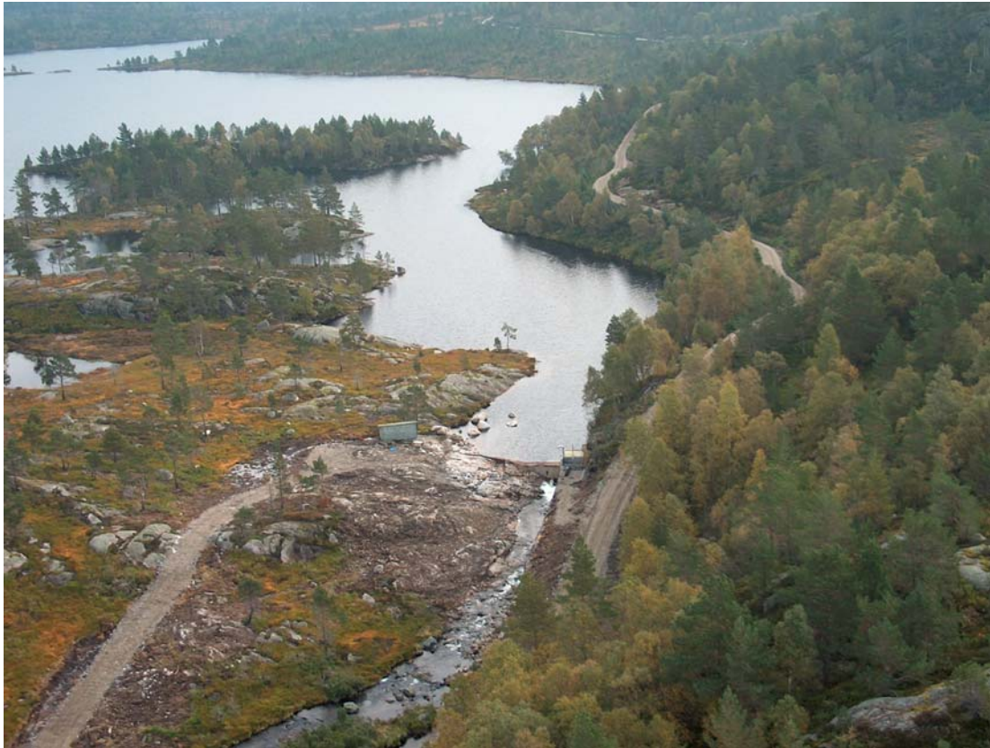
Flyfoto av eksisterende dam ved utløpet av Kleivvatn, bildet er tatt mot øst.
