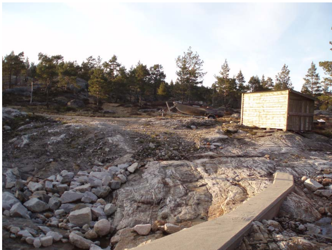
Bilde av eksisterende dam, bilde tatt mot nord
