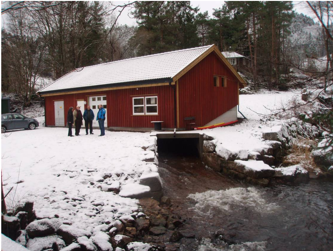
Kraftstasjon med avløp
