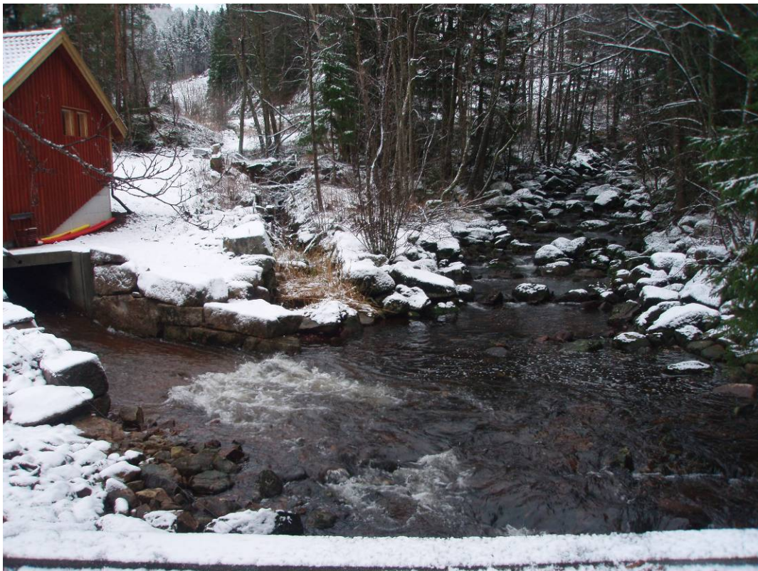
Samløp mellom avløpskanal og Storebekken.
