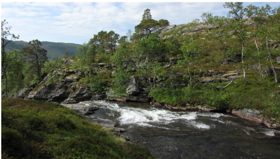
FIGUR 27: INNTAKSOMRÅDET. RØRET BLIR FØRT UT TIL VENSTRE I BILDE.
