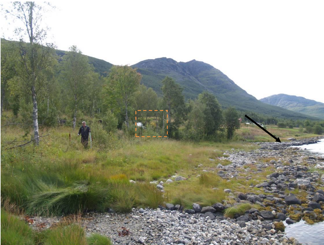
Figur 18. Kraftstasjonsområde sett nordfra. Stiplet området angir plassering, mens pilen angir utløpet av Belneselva.
