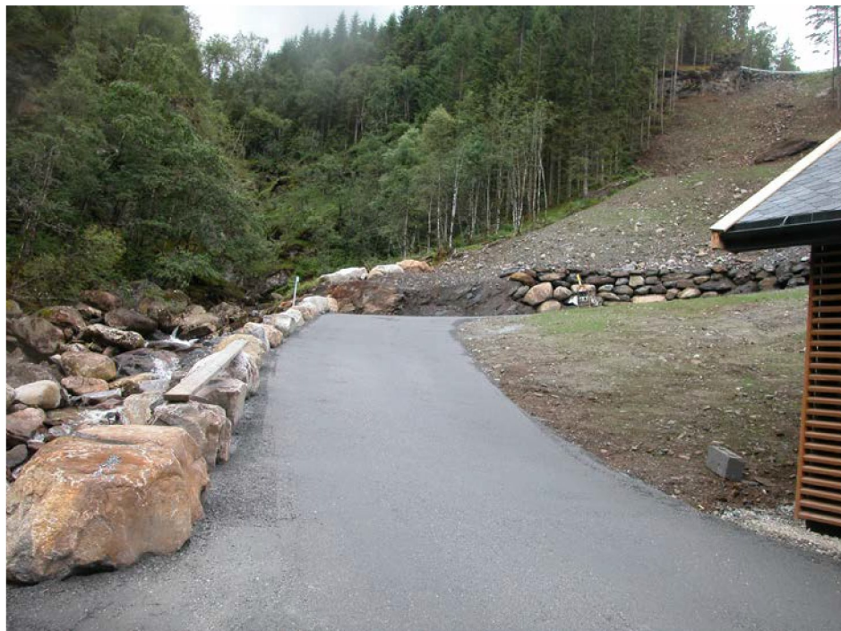
Eksempel på bratt rørgate, Rasdalen i Voss kommune.
