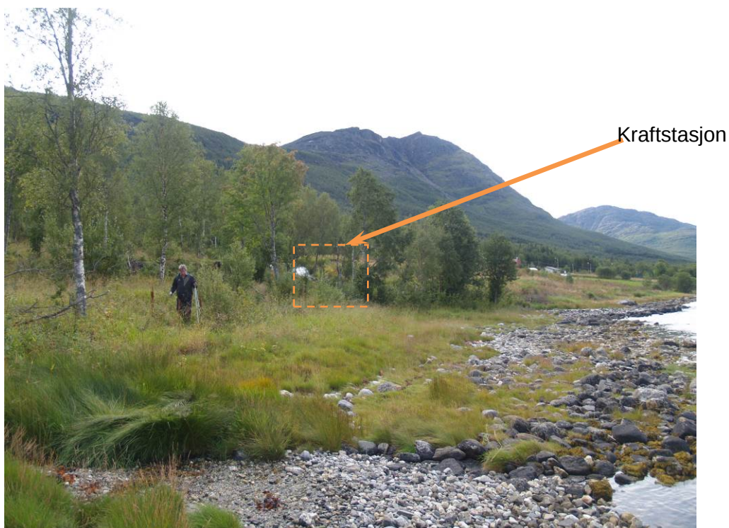
Bilde 12: Kraftstasjonsområdet sett nordfra
