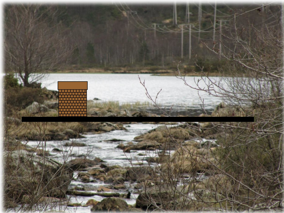
Bilde 3 Inntaksområde sett nedenfra
