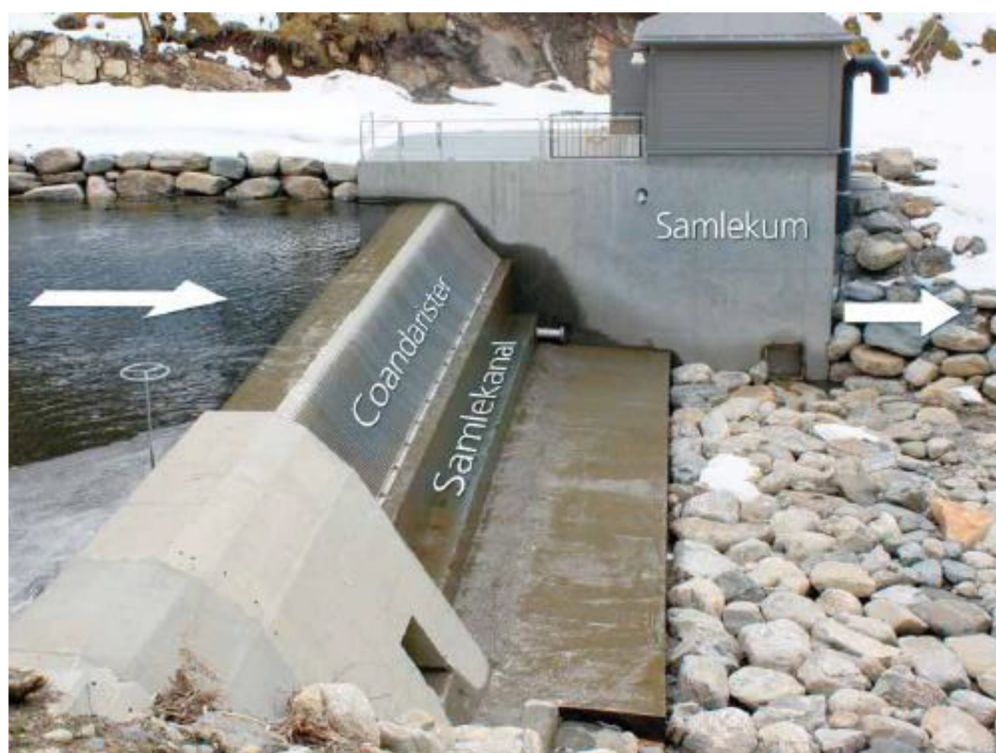
Figur 10 Skissetilsvarende inntakskonstruksjon
