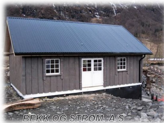
Bilde 7 Eksempel på kraftstasjon
