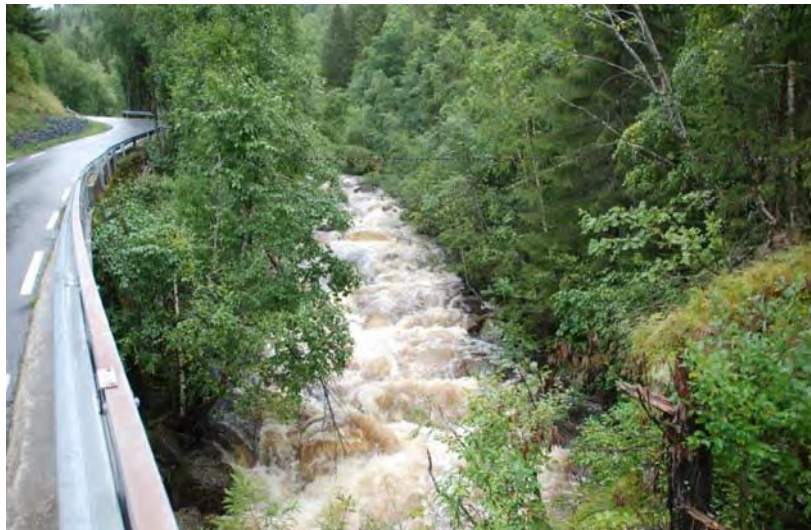
Bilde nr. 20 Rørtrase ved Wetterhus bru (bilde tatt oppstrøms)
