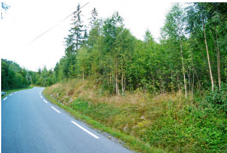
Bilde nr. 18 Rørtrase parallelt med Fv 117 (bilde tatt oppstrøms)
