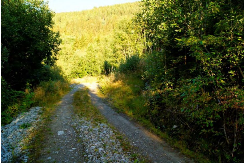
Bilde nr. 7 Rørtrase ved/i eksisterende vei (bilde tatt oppstrøms)
