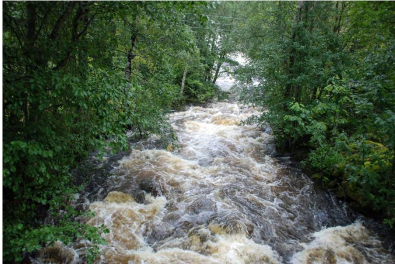
Bilde.13 Oppstrøms mot foss ved kraftstasjon. Her renner det ca 5,6 m 3 /s
