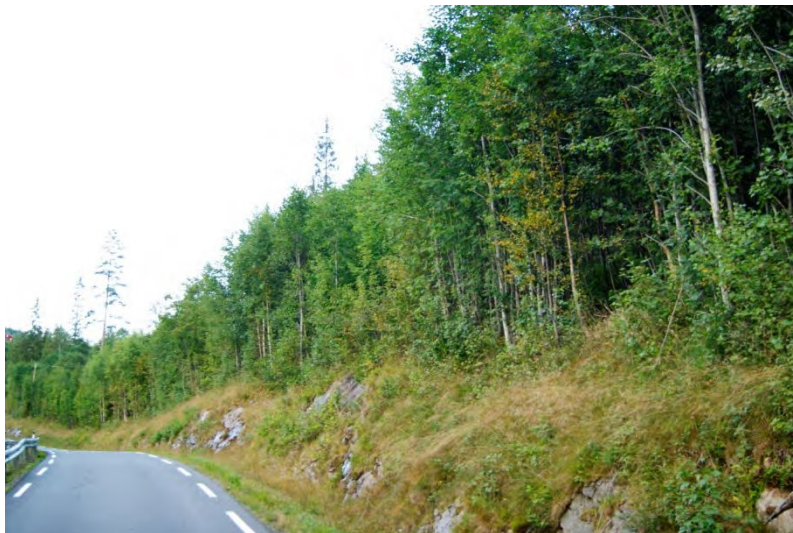
Bilde nr. 17 Rørtrase parallelt med Fv 117 (bilde tatt oppstrøms)
