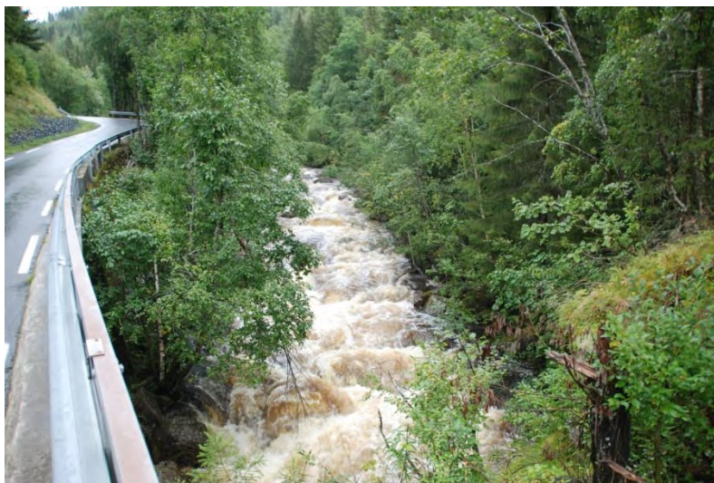
Bilde.17 Tatt på Wetterhusbru fv.117 oppstrøms mot dam. Her renner det ca 5,6 m 3 /s
