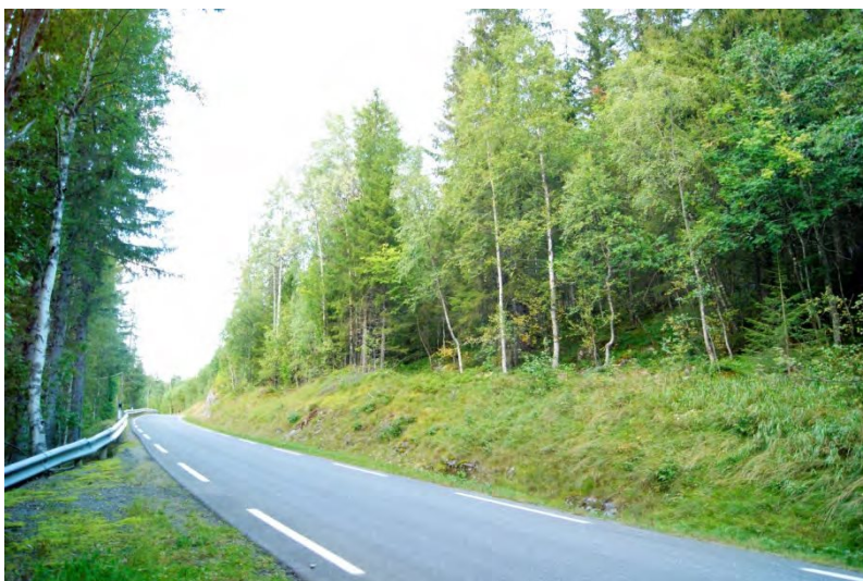
Bilde nr. 15 Rørtrase parallelt med Fv 117 (bilde tatt oppstrøms)
