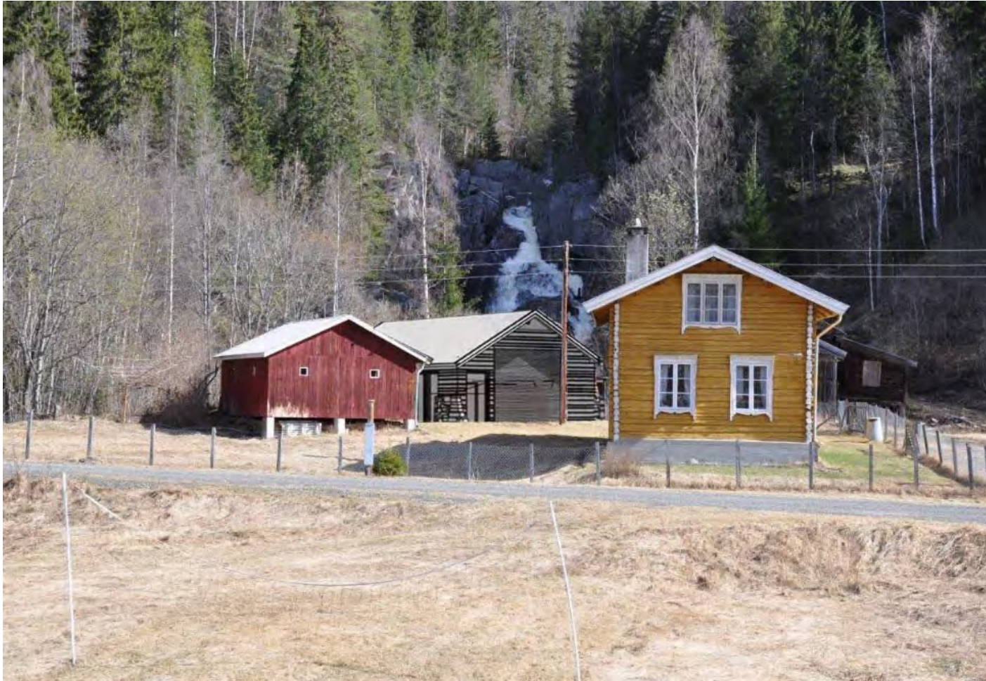
Bilde.7 Øktodden. Kraftverket i brunt mellom uthus og Møllerstugo i gult.
