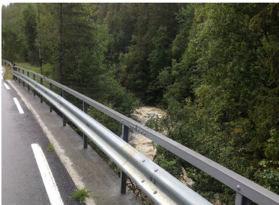
Bildet er tatt sørover fra Wetterhusbrua på fv. 117.
