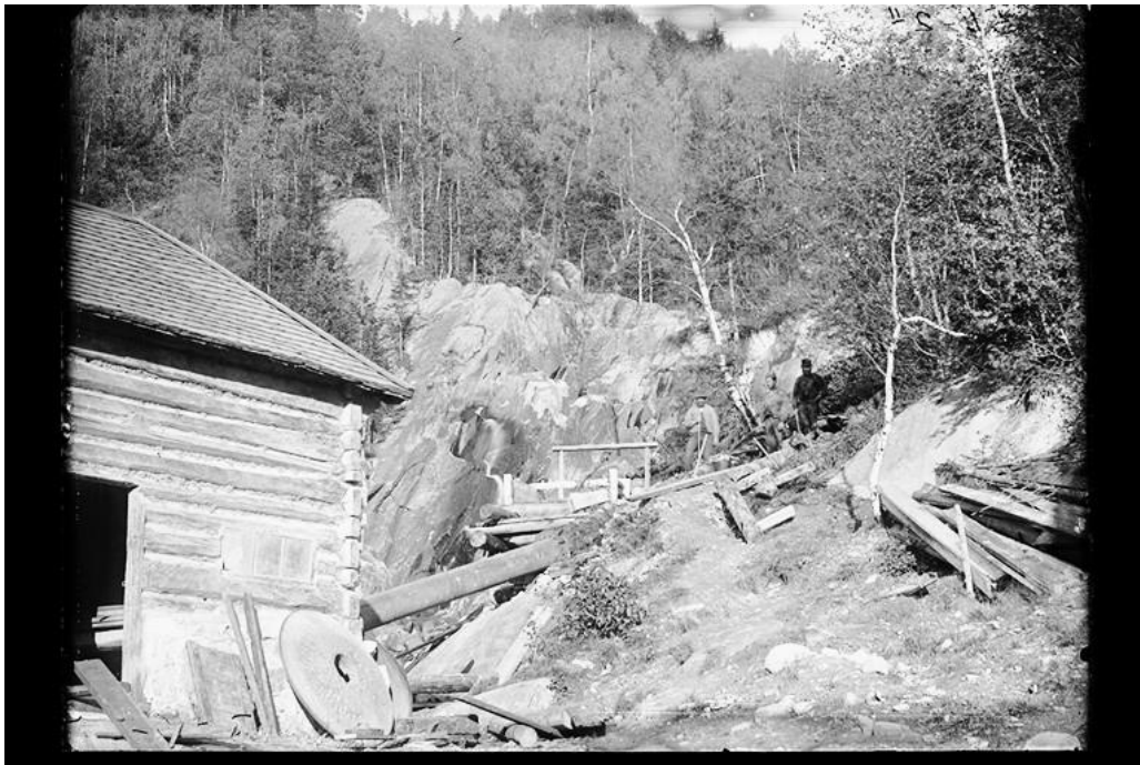
Arbeid med Rørgata 1900. Foto: Nore og Uvdal
