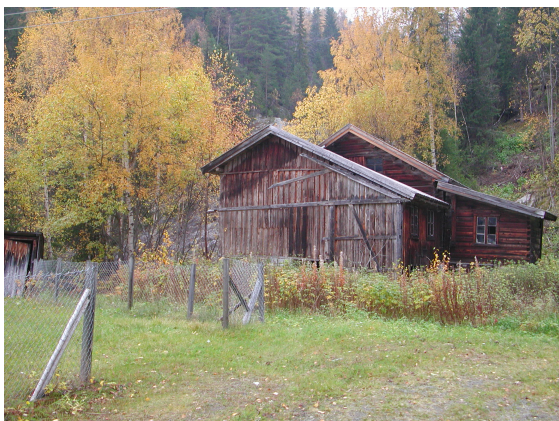
Figur 3 Den tidligere mølla i Økta i området hvor turbinhuset er planlagt.
