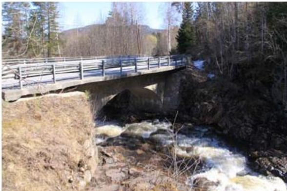
FV84, Voldenveien i bru over elva
