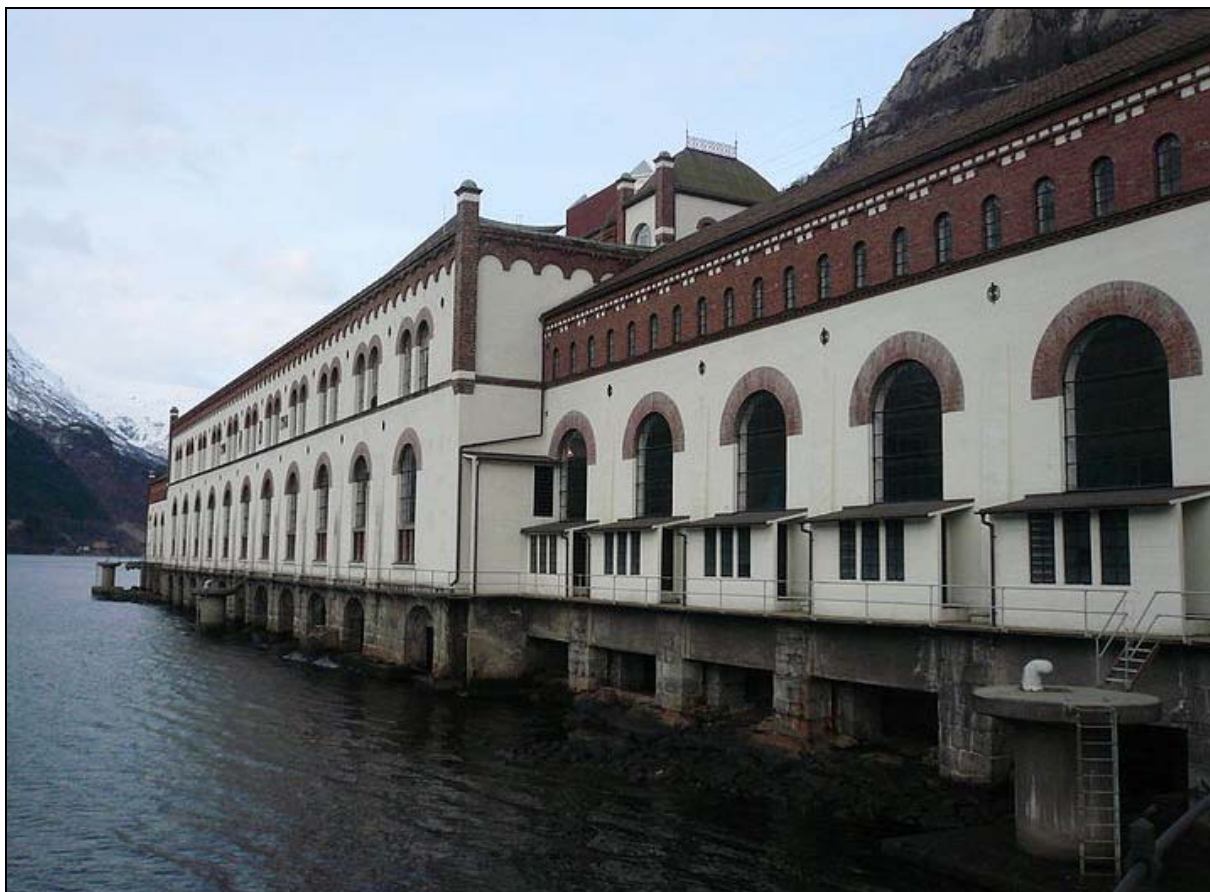
Figur 3 I nabovassdraget til Sleveåne ligger Tyssø I kraftverk (Tyssedal kraftverk), som er fredet.
