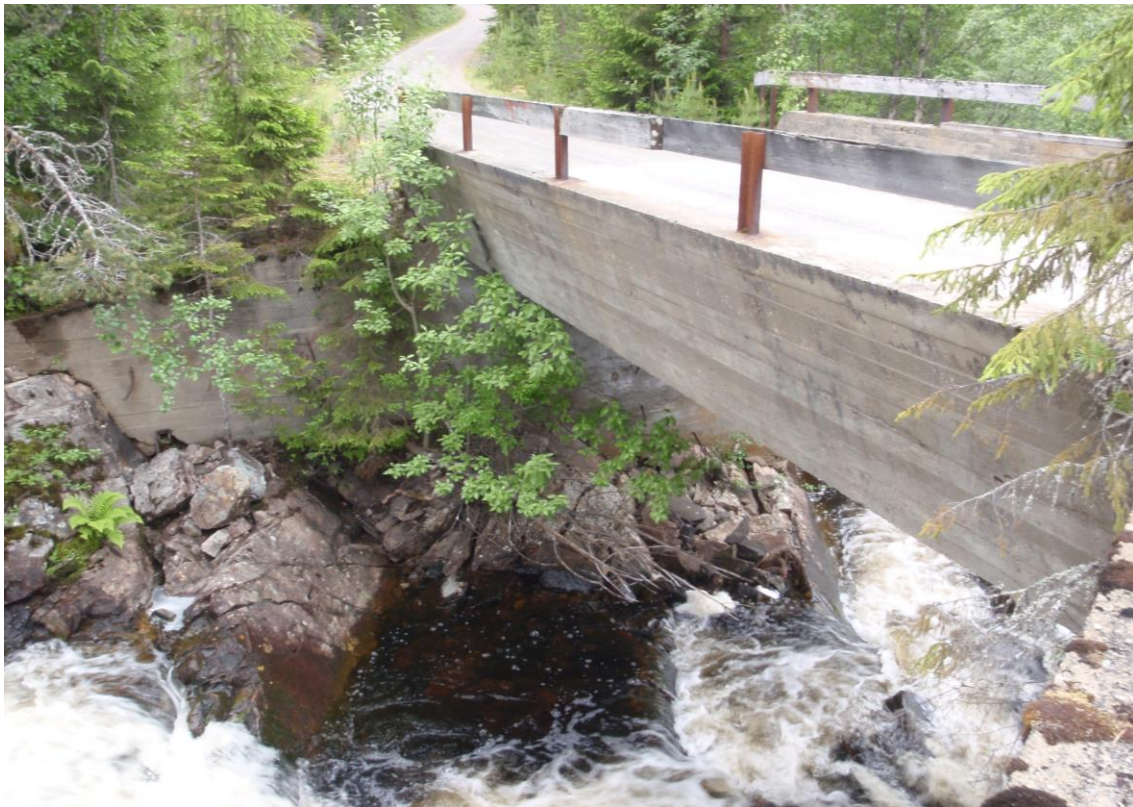
Bro over Bøla rett nedstrøms inntaksområdet. Skogsveien går opp til et hytteområde ved Øyingen.
