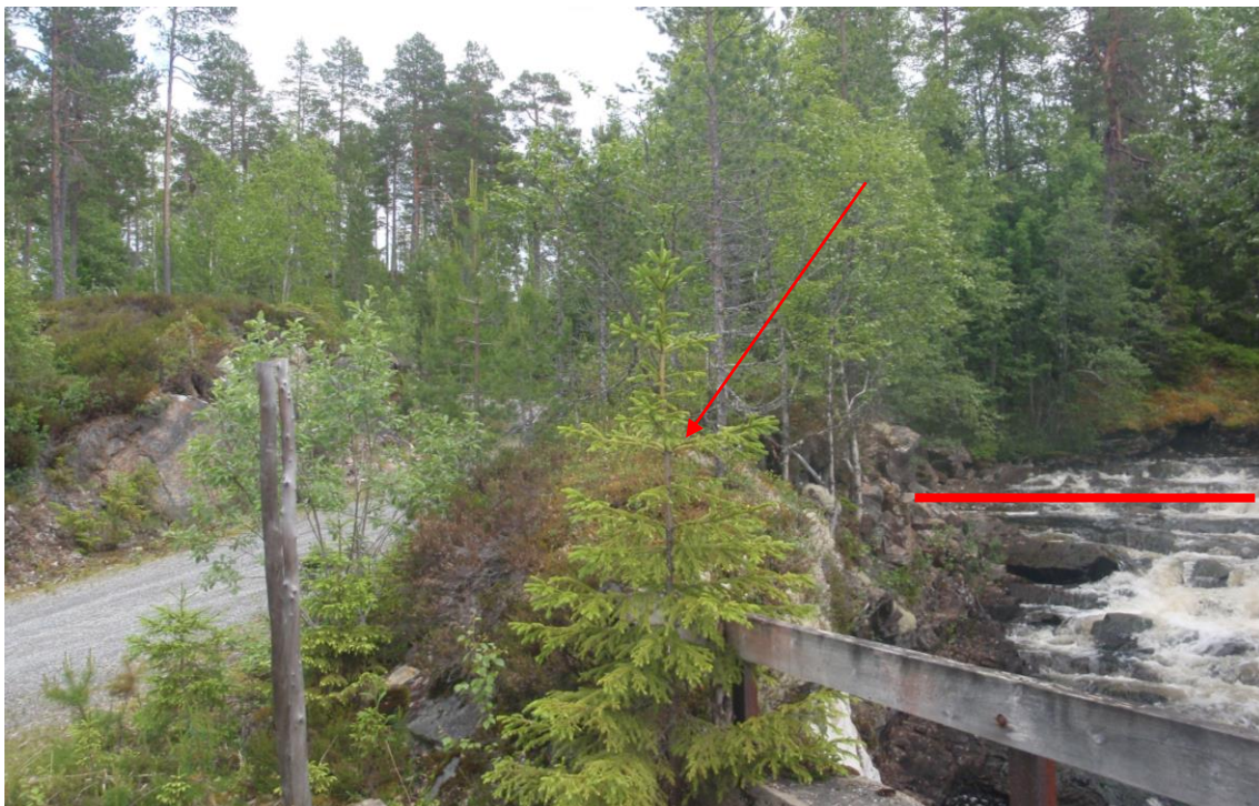
Inntaksområdet sett ovenfra. Den røde linjen indikerer plassering av inntaksdammen. Den røde pilen indikerer start på rørtraseén.
