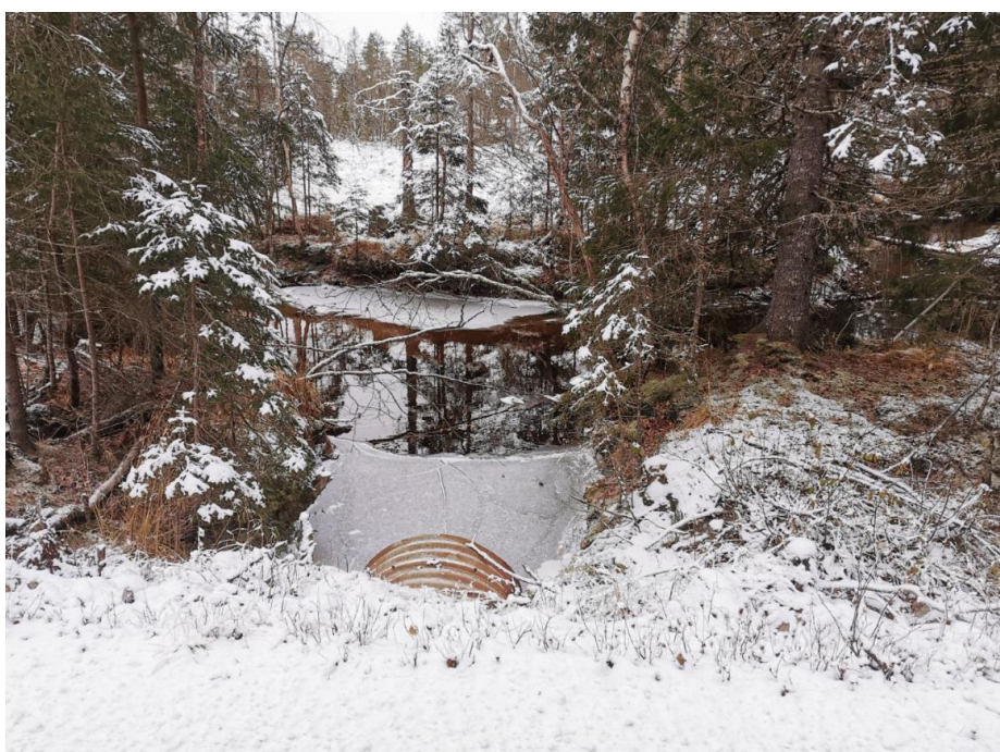
Figur 8 Utløp bekk fra Råtjønna.
