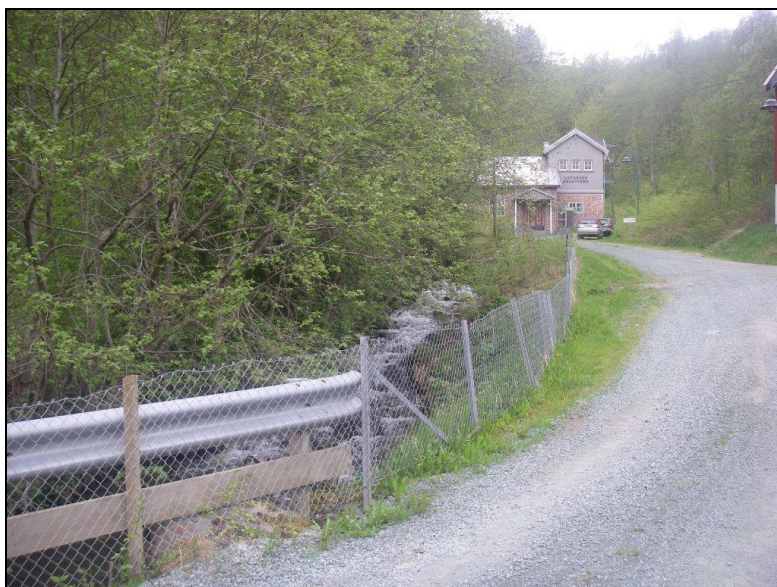
Figur 3. Loa opp mot kraftverksbygningen.
