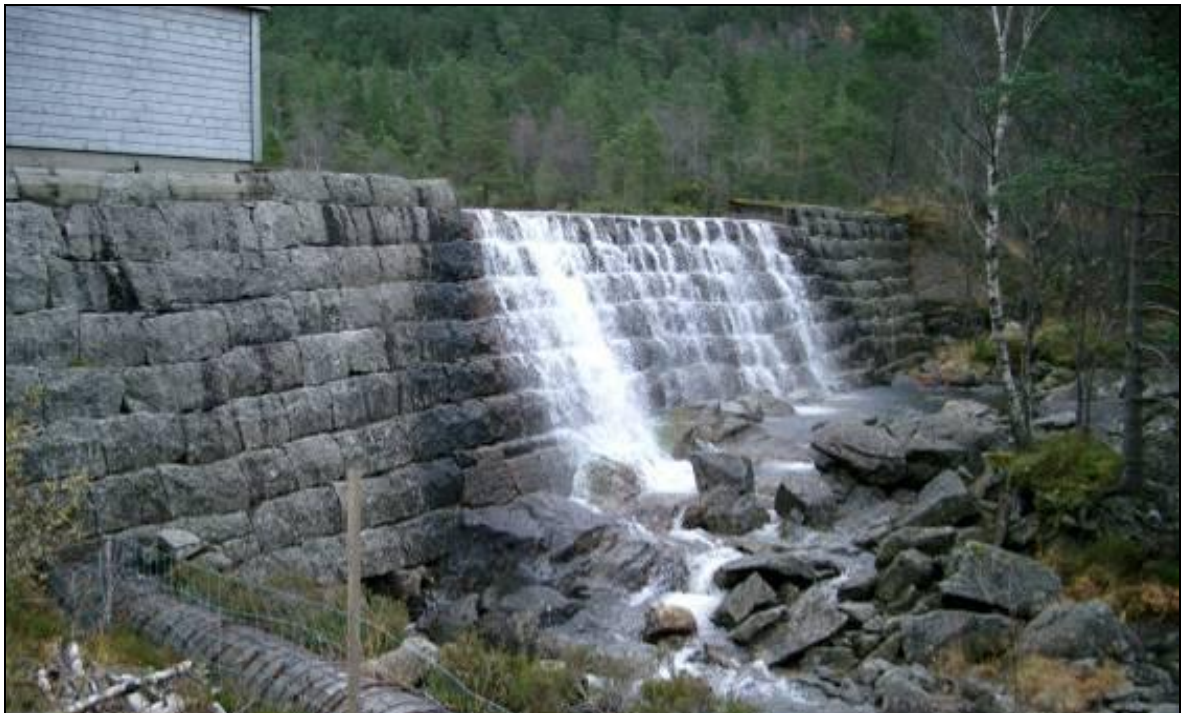
Figur 3 Elvedammen/ Stemmelandsdammen. Trerøret er i dag byttet ut med nedgravd rør.
