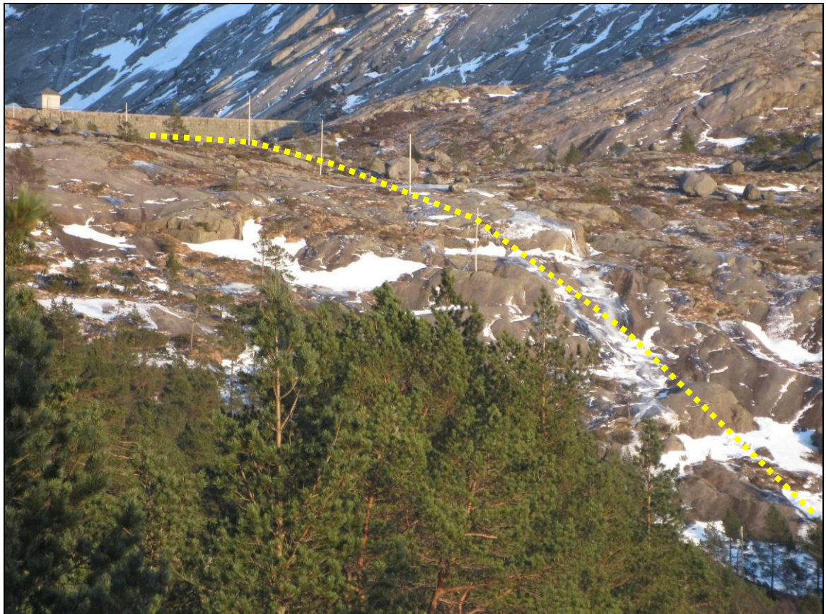
Figur 10 Røret legges på fundament over svaberget på den øverste delen.
