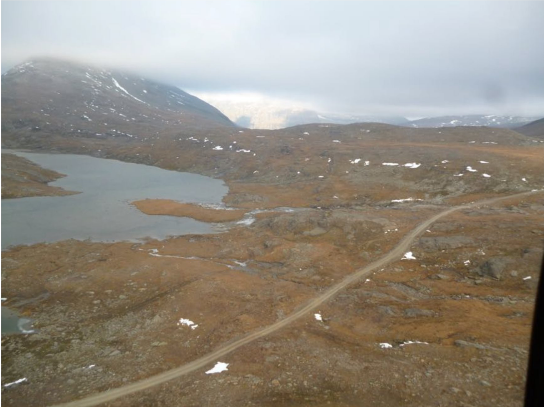
Figur 5.9. Anleggsveien i bildet krysser det planlagte deponiområdet øst for Langvatnet.
