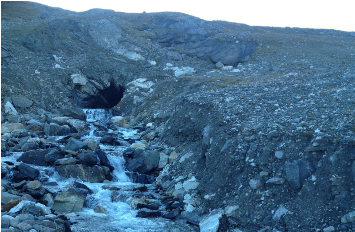
Figur 22 Utløpet av overføringstunnelen som fører utløpselva fra Halodarsvannet over til Sjørdalssmåvatnan. Foto: Morten W. Melby.
