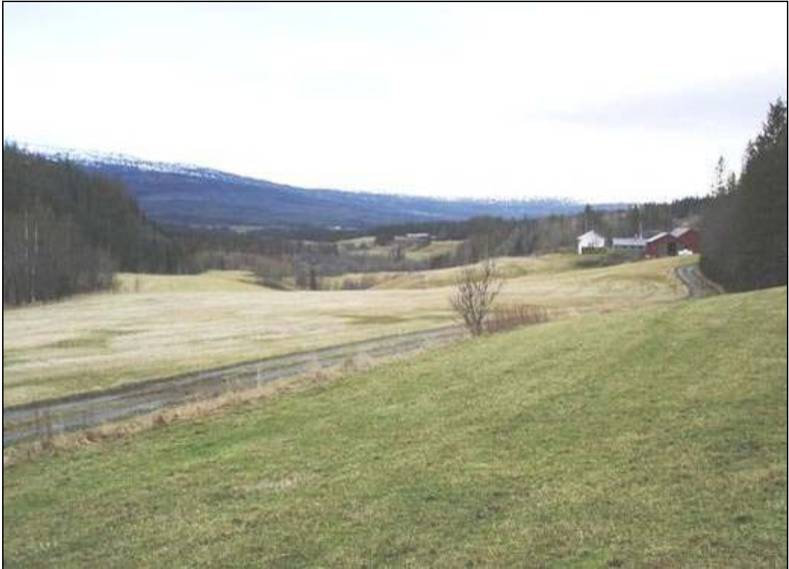
Figur 14. Nedre del av rørgata til Bryggfjelldal kraftverk graves ned i dyrket mark forbi gården Bryggfjeld (foto 8. november 2008: Einar Sofienlund).
