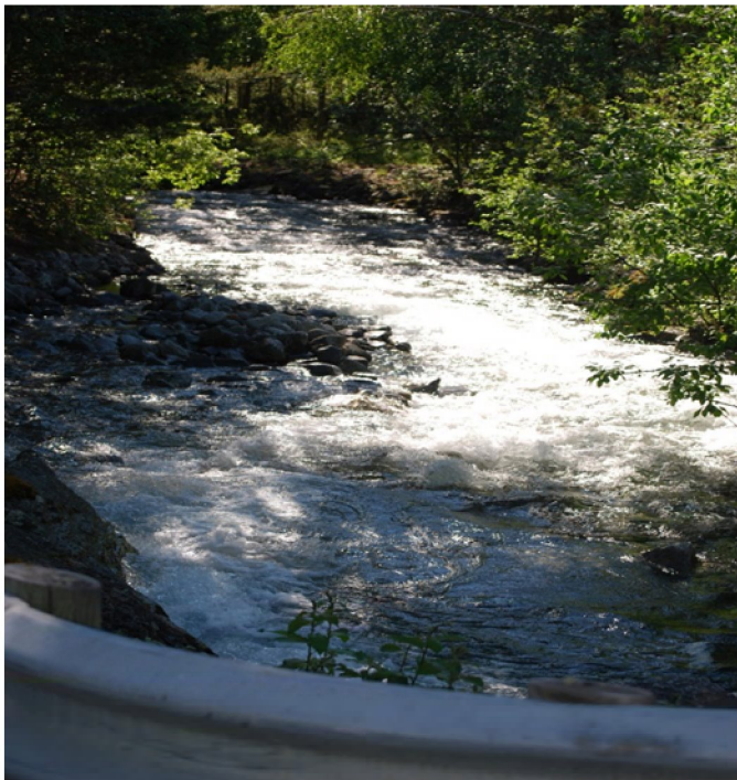
Foto 3 Området nedanfor brua ved fylkesvegen
