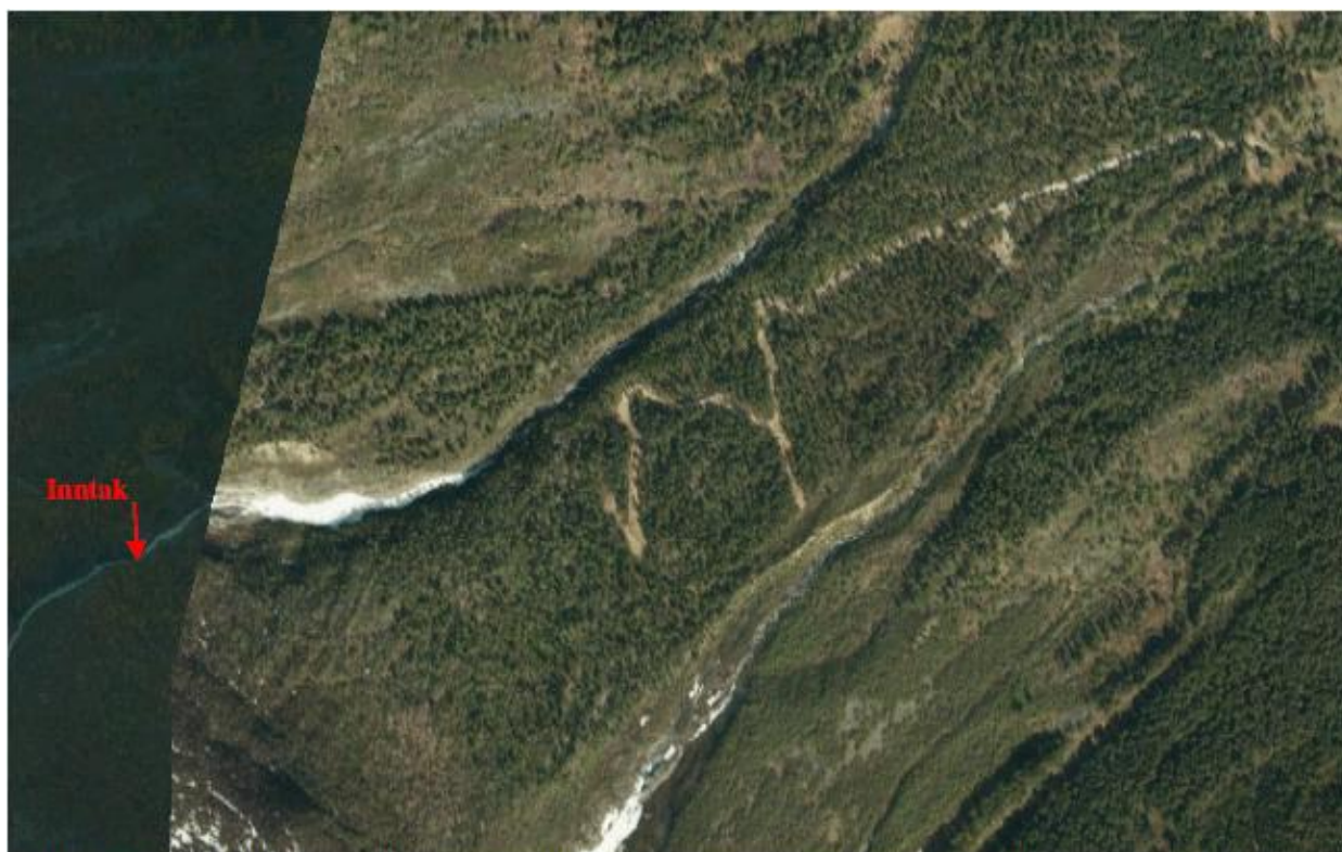
Bildet viser området fra inntak og øvre halvdel av prosjektområdet. Ny skogsbilveg sees også på bildet.
