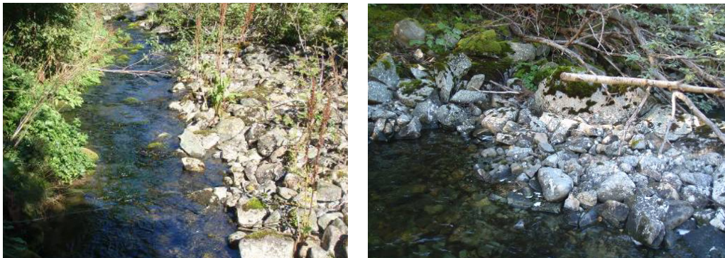
Figur 5. Riseelva. Foto til venstre: Sideløp i Riseelva ved stasjon 1. Foto til høyre: Forbygning oppstrøms sideløp.
