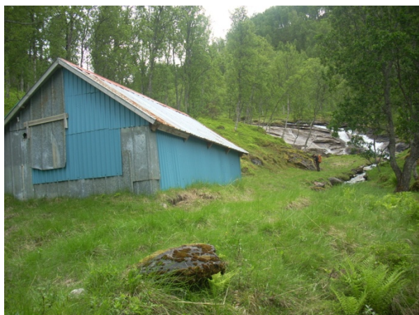
Bilde 13 – Eksisterende vanninntak ved kote 95
