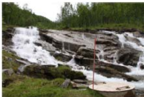
Inntakskom for Kvimes vannverk
