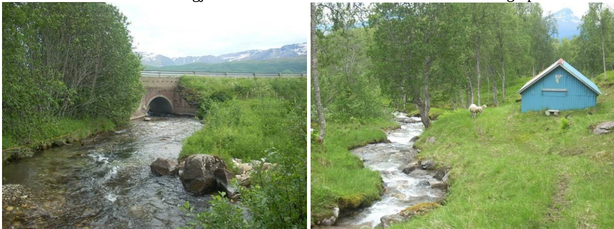
Figur 7: Bildene viser Fv 858 som krysser elva i bro rett oppstrøms utløpet, samt bygg oppsatt i forbindelse med eksisterende vanninntak ved kote 95. Fotos: Ole Roer.
