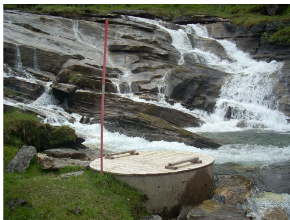
Bilde 14 – Vanninntak/kum ved kote 95
