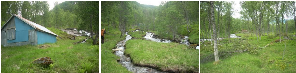
Bildene over viser vanninntak ved kote 95 med tilhørende bygg, samt videre nedstrøms elva.
