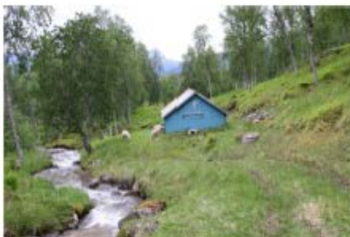
Kvimes vannverk på ca kote 95
