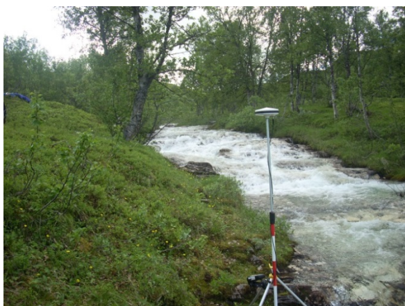
Bilde 7 – Inntak i Potraselva kote 230
