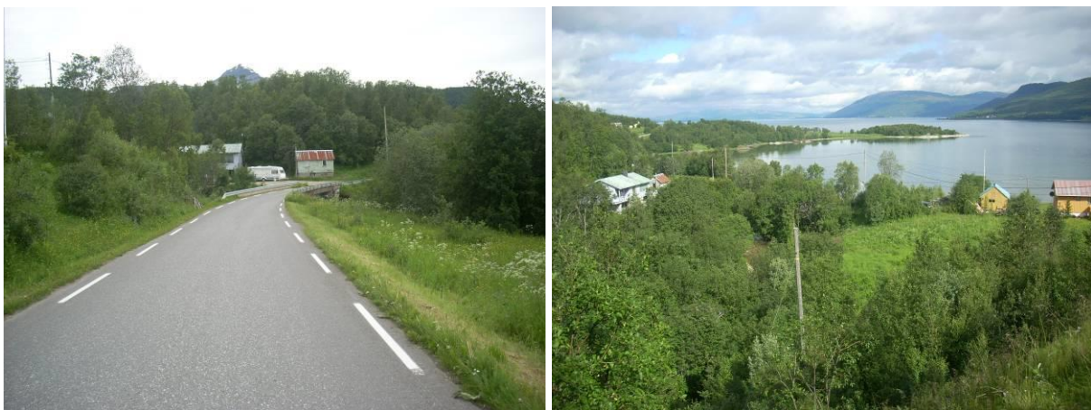
Figur 7: Bildene over viser Rv858 som krysser elva i bro rett oppstrøms utløpet, samt innmark, el-linje og bebyggelse langs nedre del av elva. Fotos: Ole Roer.
