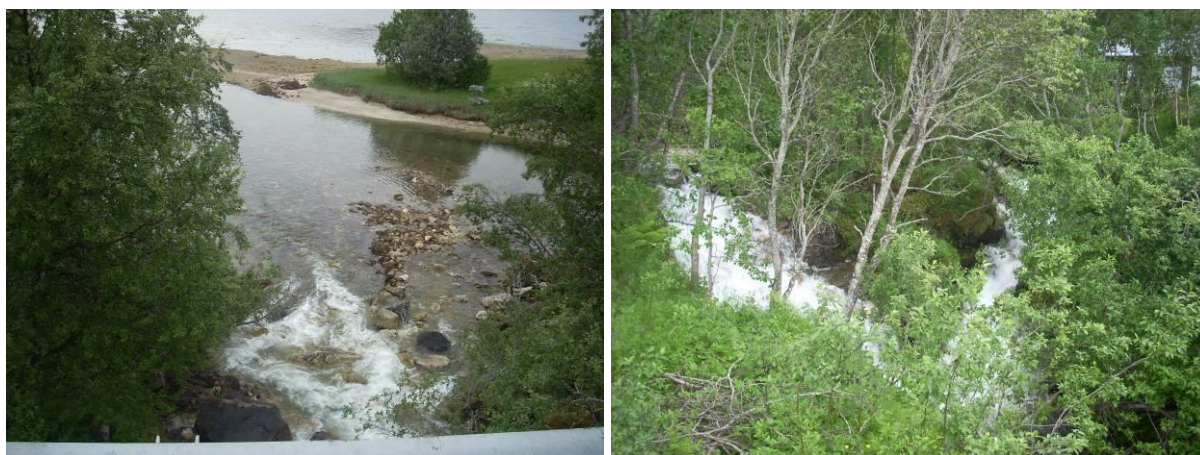
Figur 11: Bildene over viser utløpet til Potraselva med liten foss rett oppstrøms bro på Rv858 som utgjør et absolutt vandringshinder for anadrom fisk. Fotos: Ole Roer
