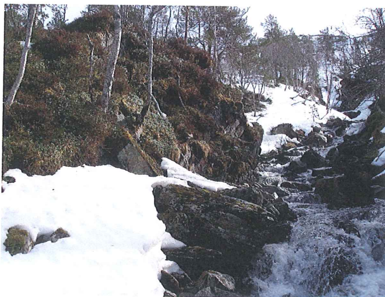
Inntak sett oppstrøms
