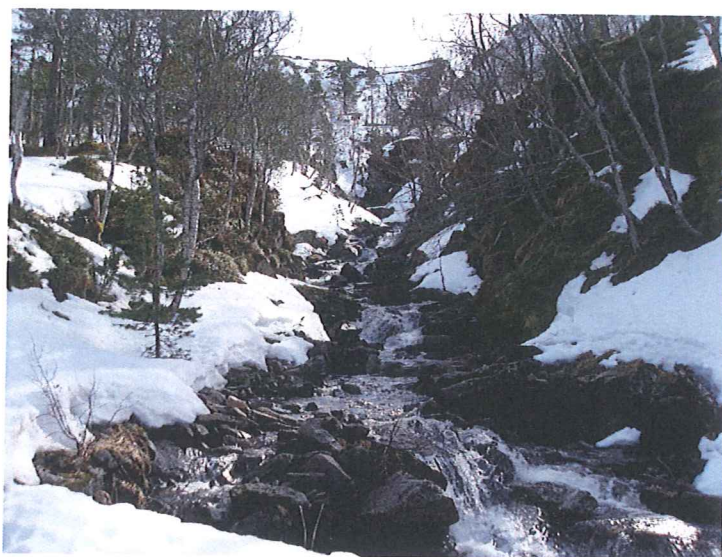
Inntak sett oppstrøms
