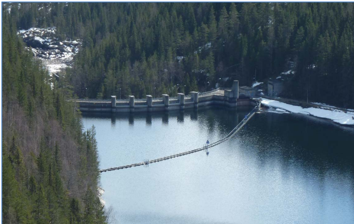
Aurdalsfjord-dammen sett oppstrøms
