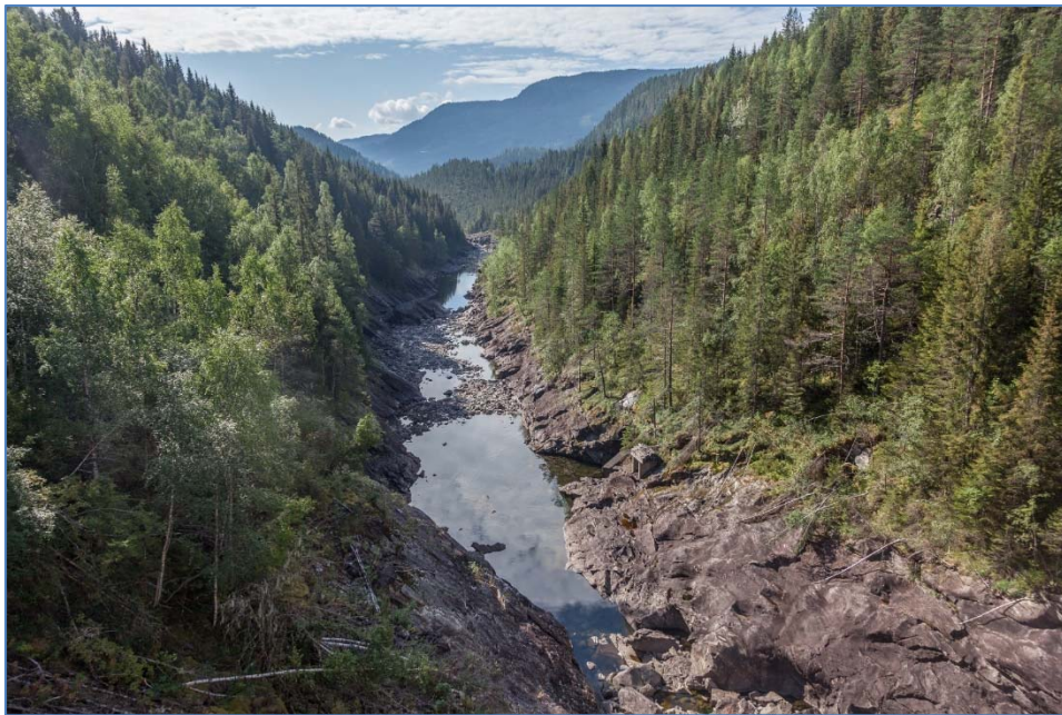
17. Bagndammen 25/6-2014. Nedstrøms. Ingen forbitapping.
