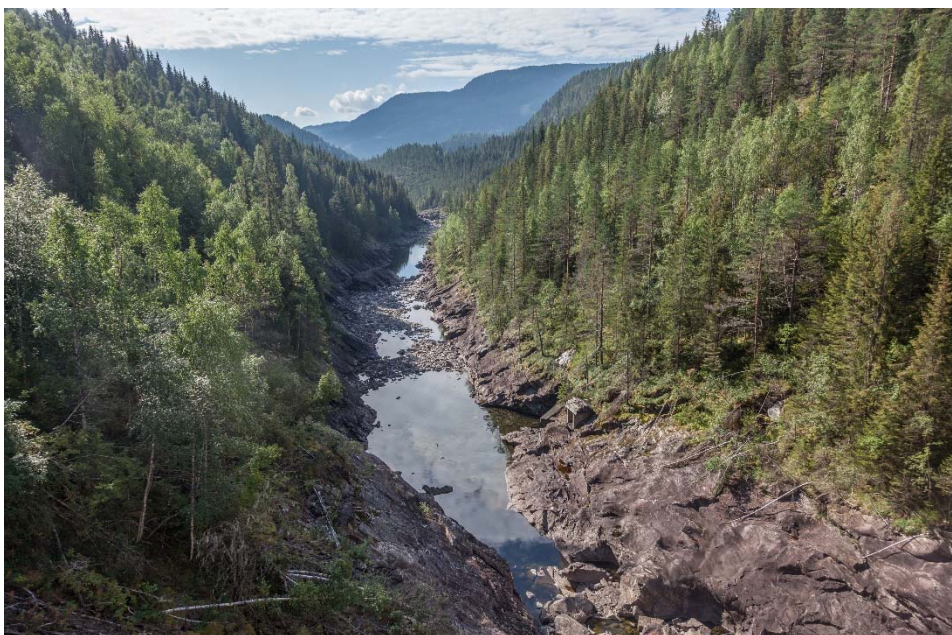
17. Bagndammen 8/8-2014. Nedstrøms. Ingen forbitapping.
