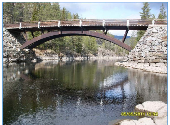
8. Fønhus bru, oppstrøms (13 m 3 /s)
