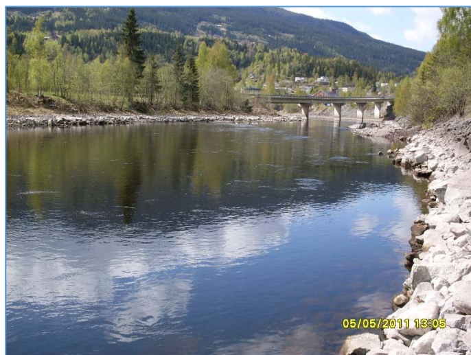
13. Bagn kraftverk, oppstrøms (9 m 3 /s)
