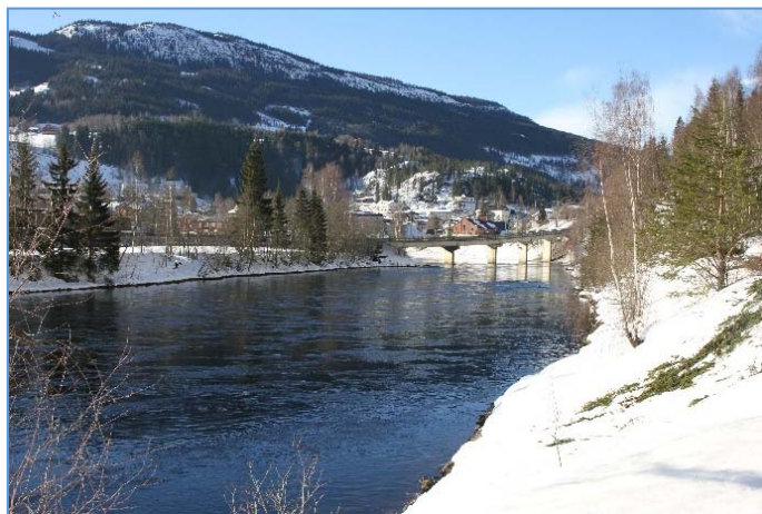
13. Bagn kraftverk 19/2-2015, oppstrøms
