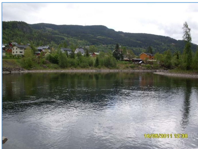
13. Bagn kraftverk, nedstrøms (23 m 3 /s) (VM Bagn 23 m 3 /s)
