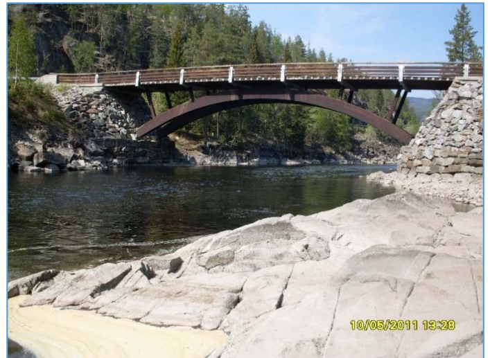
8. Fønhus bru, oppstrøms (11 m 3 /s)
