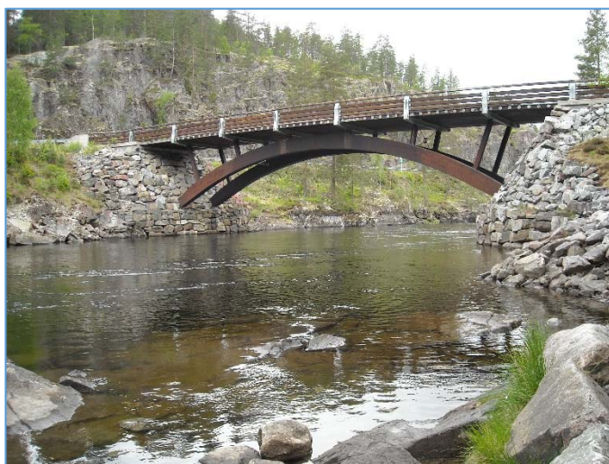
8. Fønhus bru, oppstrøms (51 m 3 /s)
