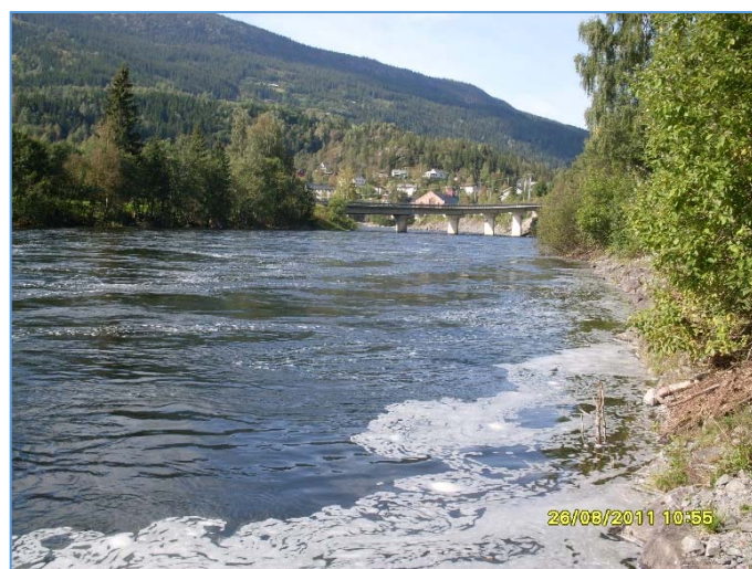
13. Bagn kraftverk, oppstrøms (132 m 3 /s)
