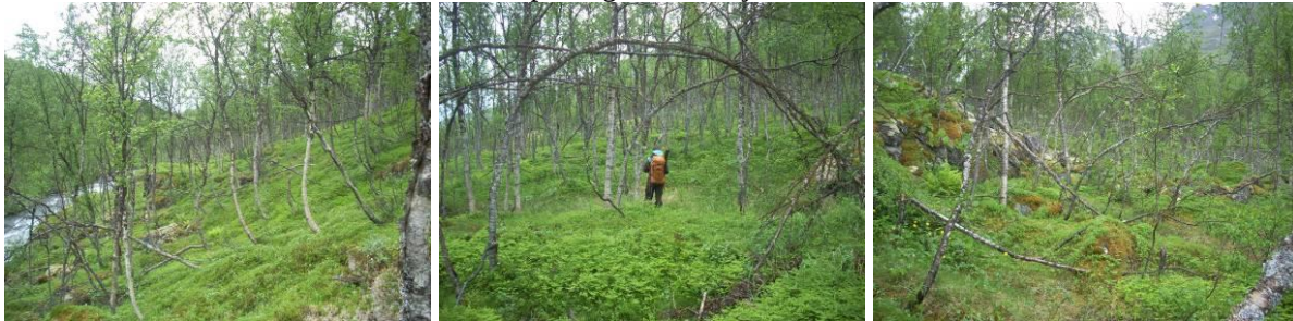
Bildene over viser øvre deler av rørgata fra inntak i Tverrelva kote 310 og videre nedover.
