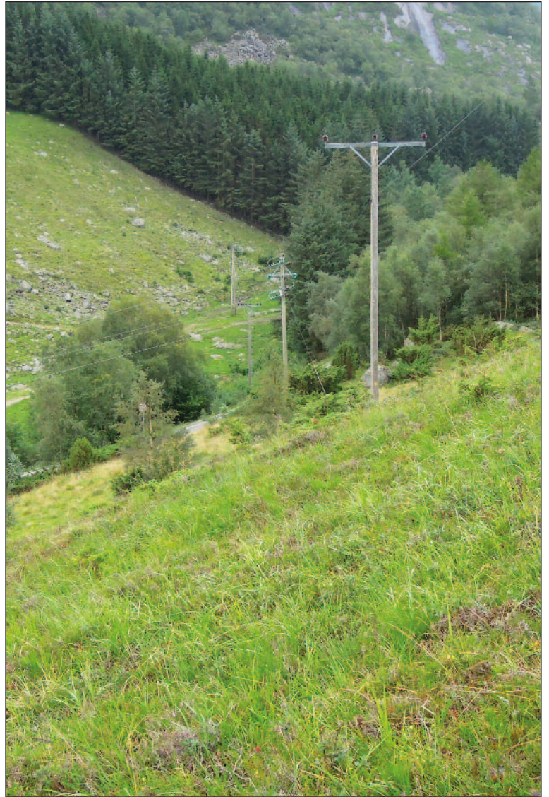
Figur 5.7 22 kV mastearrangement med tremaster. Bilde 3 Område hvor ny 22 kV linje vil knyttes til eksisterende nett. Foto: Ambio Miljørådgivning.
