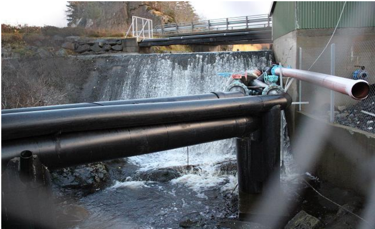
Figur 7. Bilde av demningen ovenfor settefiskanlegget som ble bygget på 1600-tallet
