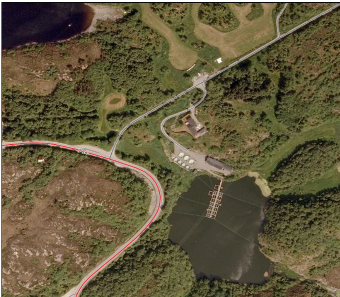
Figur 5. Vikan Settefisk AS med merdanlegg i Hundvatnet samt påvekstanlegg på land og klekkeri i hus ved Hundvatnet. Både klekkeri og påvekstanlegg henter vann fra vanninntak i Storvatnet øverst. Ledningene ligger nedgravd på strekningen.
