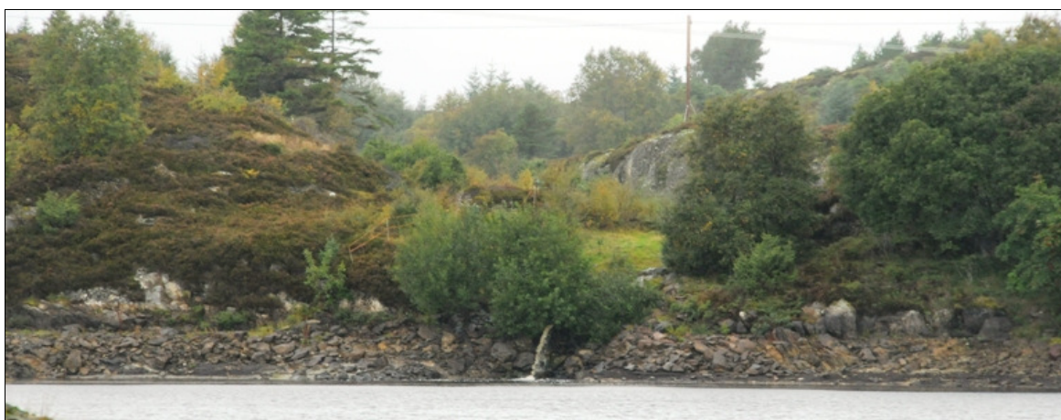
Figur 10. Øverst og i midten: Innløpselv til Storvatnet midt på sørsiden er gravd ut i jord uegnet for gyting. Det ble ikke påvist fisk ved elektrofiske i denne bekken. Nederst: Innløpselven fra vest er lagt i rør og ikke tilgjengelig for oppvandring av fisk selv ved fullt magasin.
