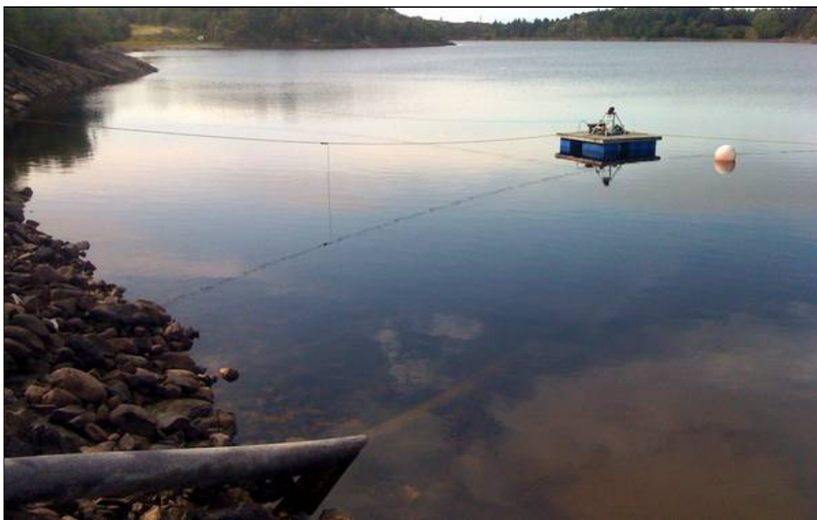
Figur 4. Vikan Settefisk AS sitt magasin i Storvatnet på Hitra 21.august 2009, med omtrent 2 m nedtapping (øverst) og flåten med pumpestasjon og ledning (nederst). Ledningene på det øverste bildet er uttaksledninger for drikkevann.
