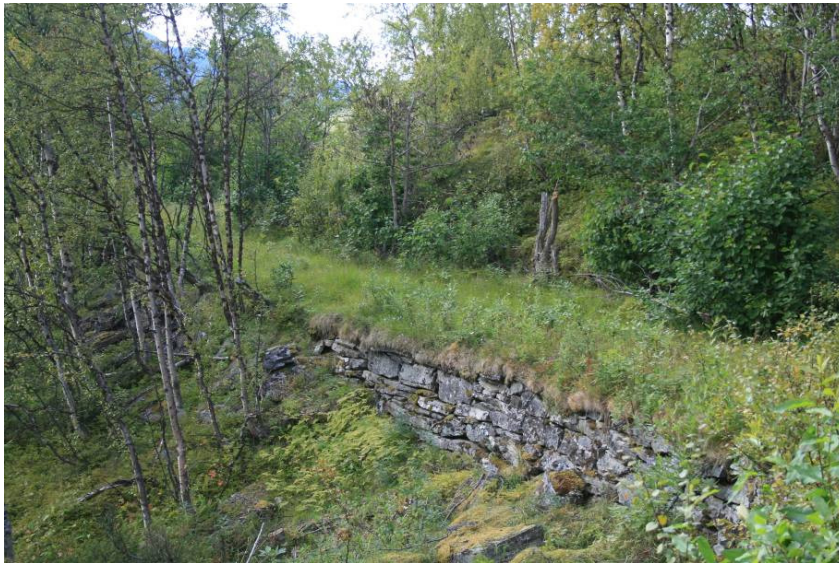
5-5 Deler av Markedsvegen ligger ovenfor dagens E8. Her ser vi et gjengrodd parti der tørrmuren fortsatt er godt synlig. Foto: M. Mortensen, Sweco, august 2010.
