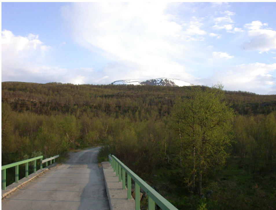
Figur 4.2. Utsikt sørover mot nordvestlige del av utbyggingsområdet, ved bru ved Dalmunningen. Foto: Svein Morten Eilertsen, Planteforsk Tjøtta fagsenter.
