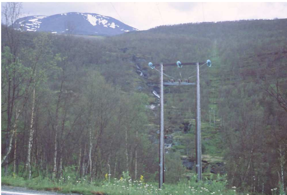
Figur 5.1. Illustrasjonsbilde av eksisterende mastetrase ved kryssing av hovedvegen (E8) ved Rihpojohka. Planlagt trasé ved utbyggingen av Rieppi vindkraftpark går langs en annen eksisterende trasé bak åsen til høyre i bildet. Traséen planlegget med noe høyere og bredere master enn vist på dette bildet. Foto: Dordi Kjersti Mogstad, Planteforsk Tjøtta fagsenter.
