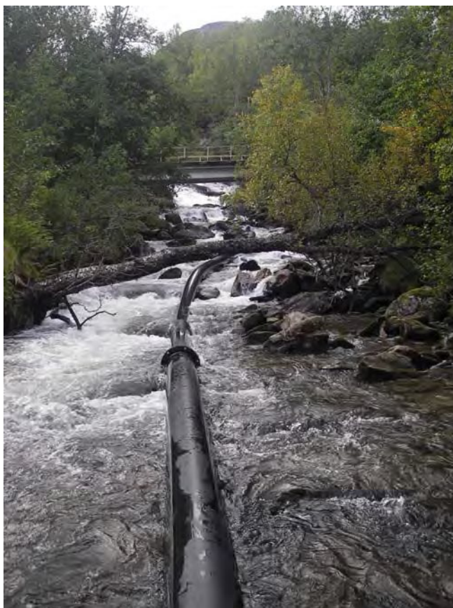
Broen over Dudalselva, kommunal veien
