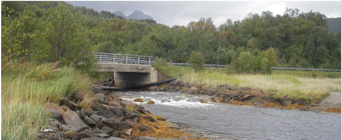
Figur 4 Brua til FV825 over Dudalselva
