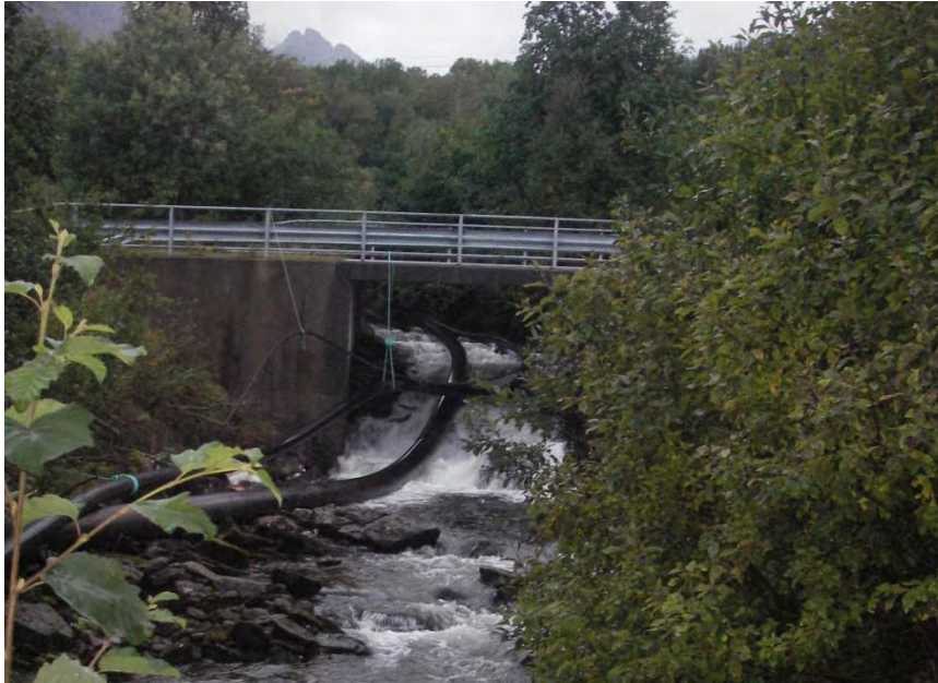
Figur 3 Bru over lokal veg
