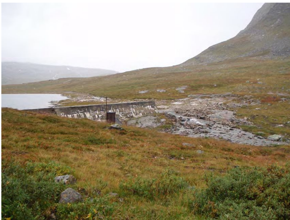
Dam ved Foldvikvatnet
