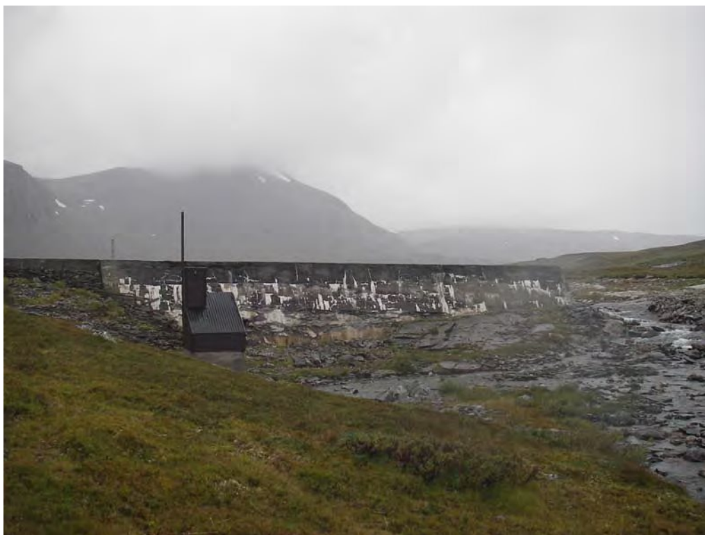
Dam og lukehus ved Foldvikvatnet
