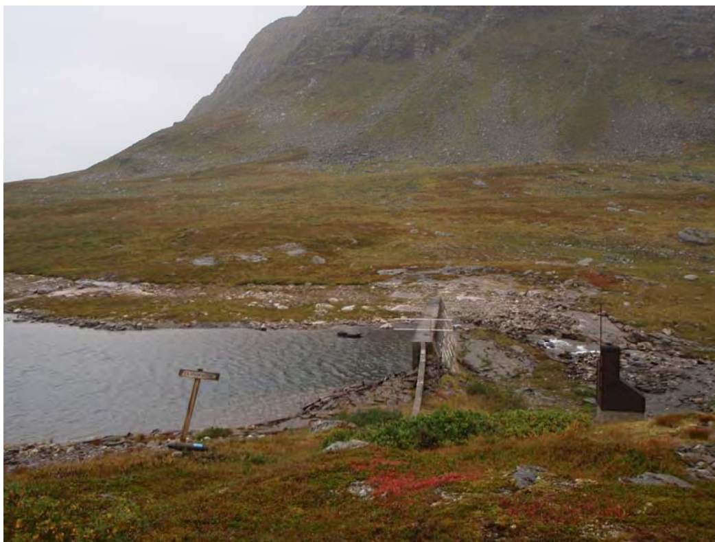
Dam ved Foldvikvatnet
