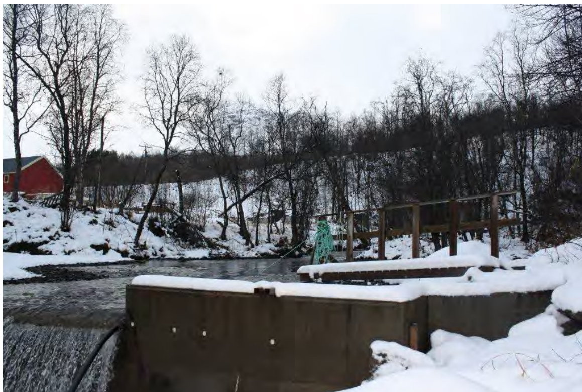
Området like sør for planlagt kraftstasjonsplassering
