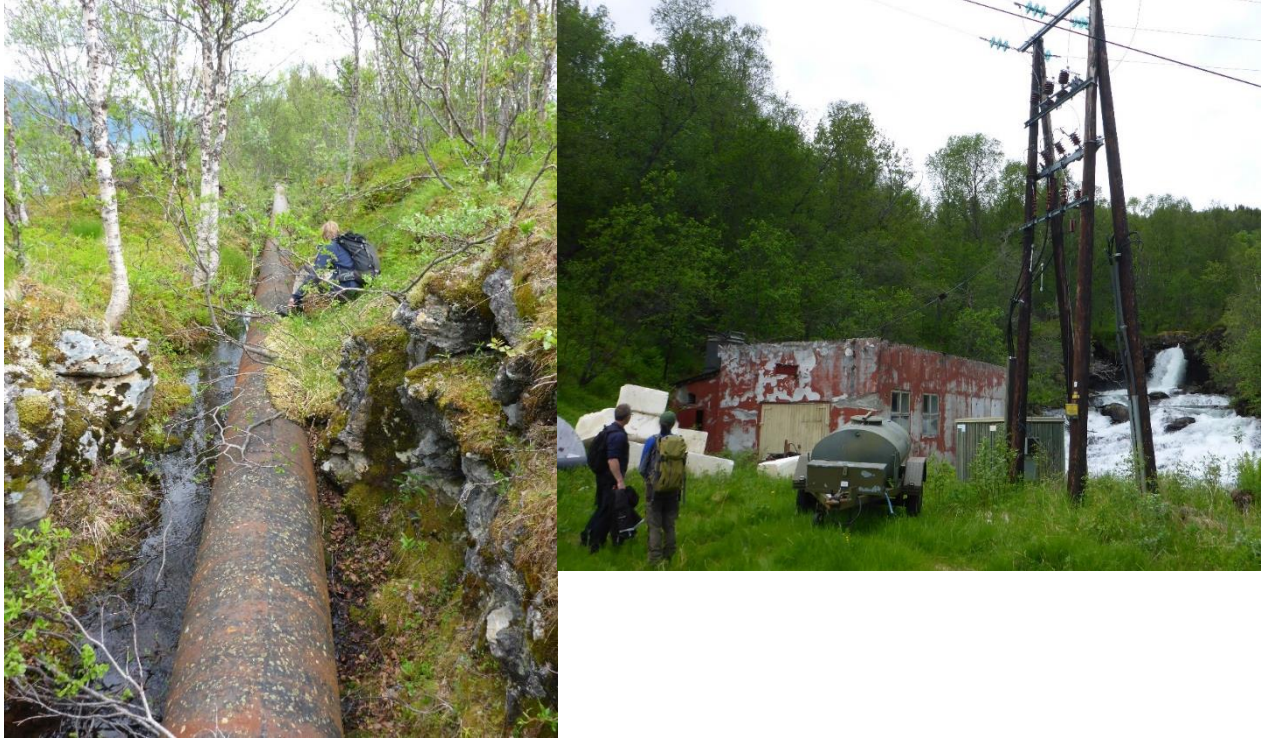
Figur 11 Kulturminner etter gamle Foldvik lysverker. Rørgate til venstre. Kraftstasjon til høyre.
