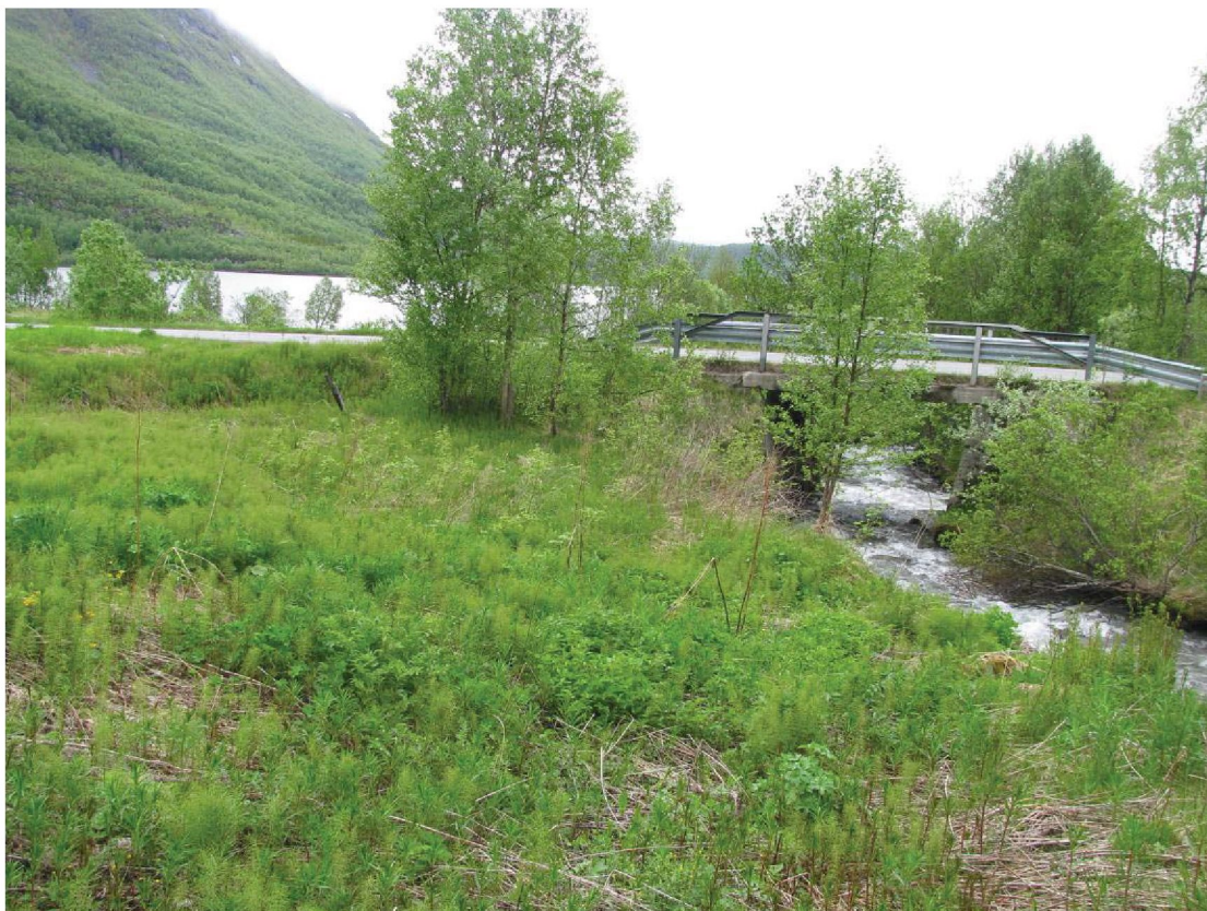
Segelelva like nedstrøms område for kraftstasjon
