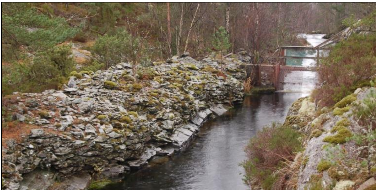
Figur 2. Utløpet fra Kvitebergsvatnet er kanalisert og senket tidligere, sannsynligvis for å hindre flomoppstuvning for landbruksarealene i indre deler av innsjøen. Dette arbeidet er ikke av nyere dato.
