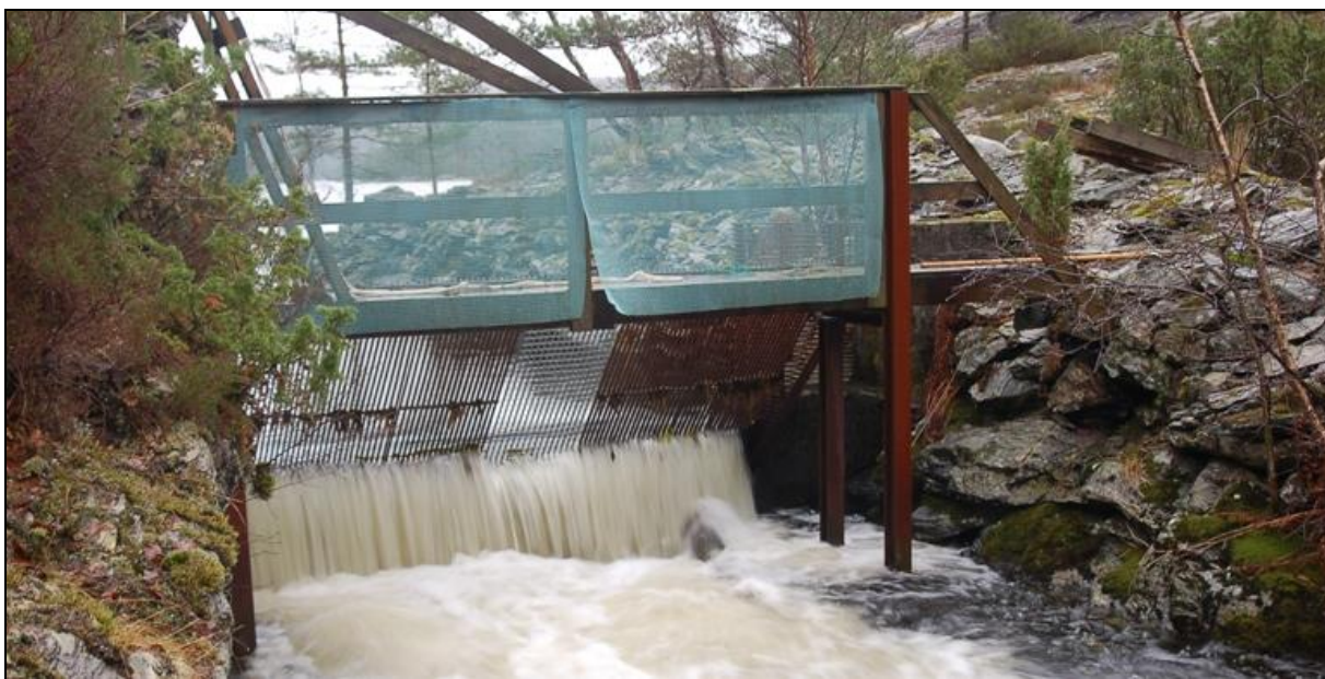
Figur 3a. I enden av den utskutte kanalen i figur 2 , er det etablert en dam på 80 cm høyde og vel 2,5 meters bredde. I forbindelse med vannuttaket til Ølve Bruk AS, er det siden etablert et oppvandringshinder for anadrom fisk i forbindelse med dammen i utløpsosen.
