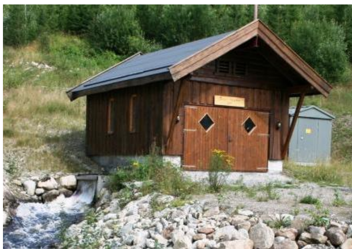
Figur 10. Kontraroterande turbin under bakken. Bilete syner ferdig montert kraftstasjon med tilkomst i eit lite hus oppå bakken.
