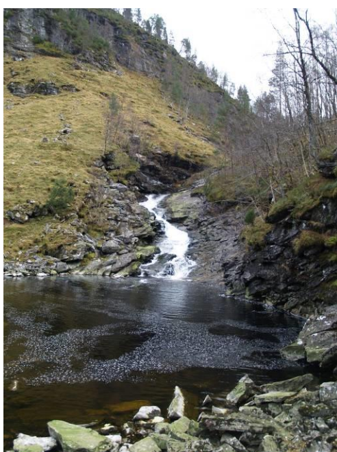
Figur.10. Ved inntakspunkt for alternativ 2- utbygging.
