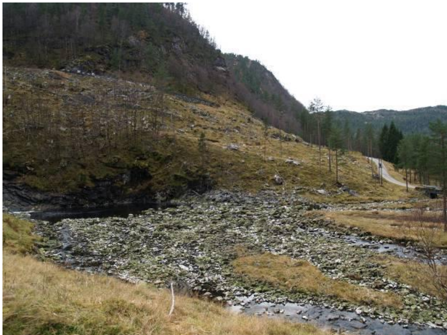
Ved inntakspunkt for alternativ 2-utbygging
