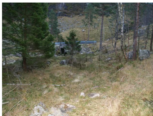
Figur 7. Langs planlagt trasé for rørgate på sørsida av elva, oppstrøms kraftstasjonen.
