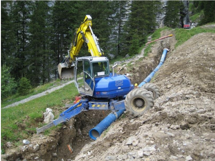
Rørlegging med minimalt inngrep. Tilkomsveggar er ikkje nødvendige
