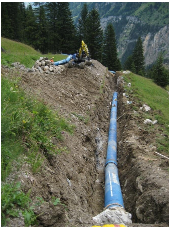
Ferdig lagt rørgate, før tildekning med naturlige/stadlege massar.
