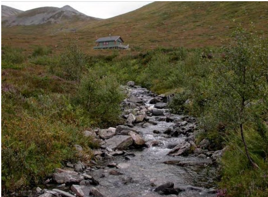
Årdalselva, ved inntaket i den nordre grein
