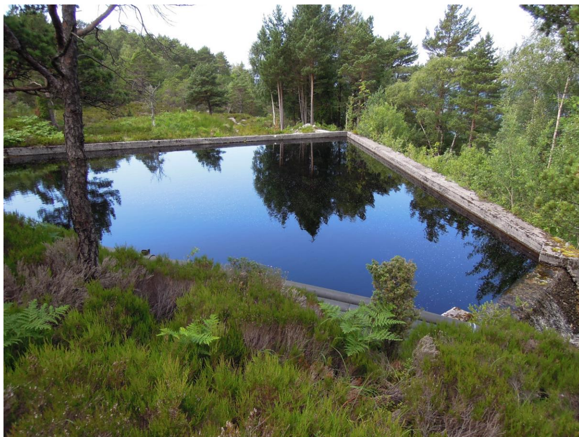
Figur 5.3. Det lille magasinet til Rutledal vannverk
