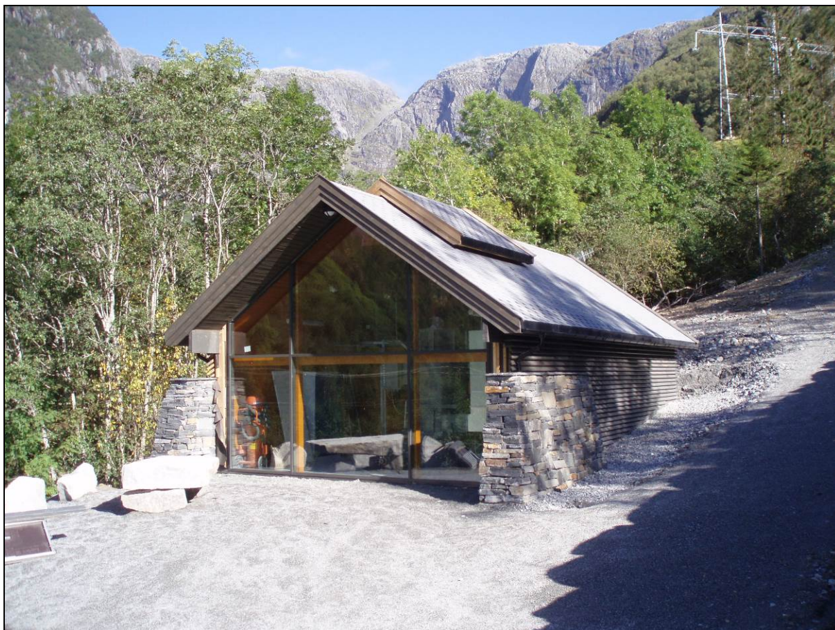
Figur 22. Eksempel på kraftstasjonsbygning med god arkitektonisk utforming og materialbruk tilpasset omgivelsene (Gjerde kraftverk).
